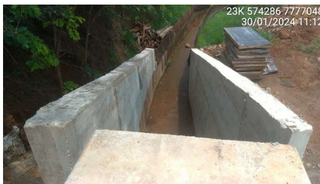
Foto 5.6 – Adequação da seção hidráulica do canal à jusante da galeria em aduelas.
