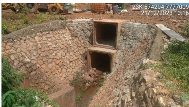
Foto 5.3 – Instalação de aduelas de concreto apoiadas nas aduelas existentes.
