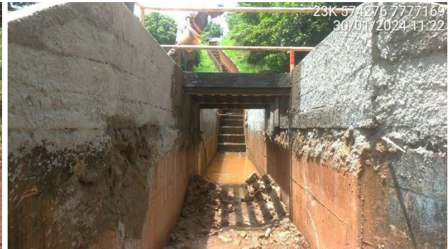
Foto 5.10 – Adequação da parede do canal e implantação de grade para passagem de veículos.
