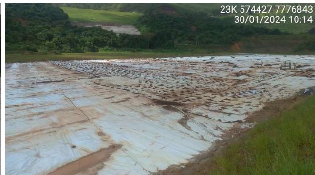
Foto 5.2 – Reservatório da barragem parcialmente impermeabilizado.
