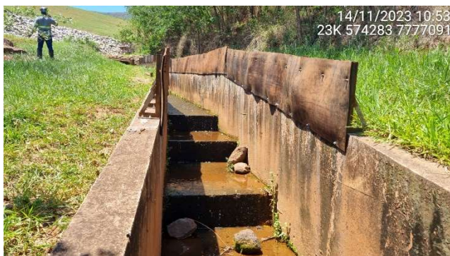
Foto 5.7 – Detalhe da adequação da parede do canal extravasor.
