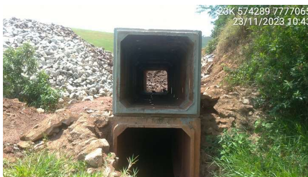
Foto 5.4 – Instalação de aduelas de concreto apoiadas nas aduelas existentes.
