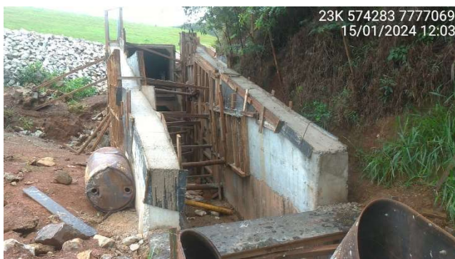
Foto 5.5 – Adequação da seção hidráulica do canal à jusante da galeria em aduelas.
