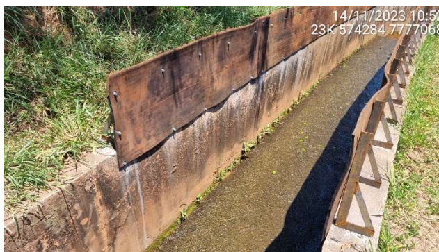
Foto 5.8 – Detalhe da adequação da parede do canal extravasor.
