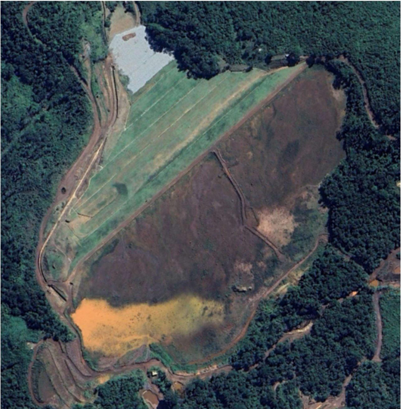
Figura 4.2 – Imagem da Barragem B1-Auxiliar – Mina Tico-Tico. (Fonte: GoogleEarth® - Maio/2023).
