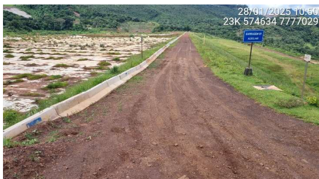
Foto 5.1 – Vista da crista com a implantação das barreiras New Jersey .
