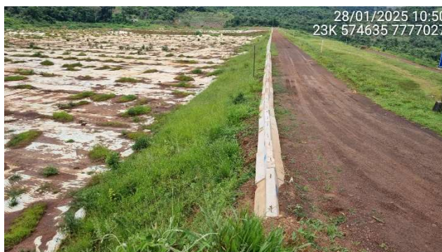
Foto 5.2 – Detalhe da barreira New Jersey .
