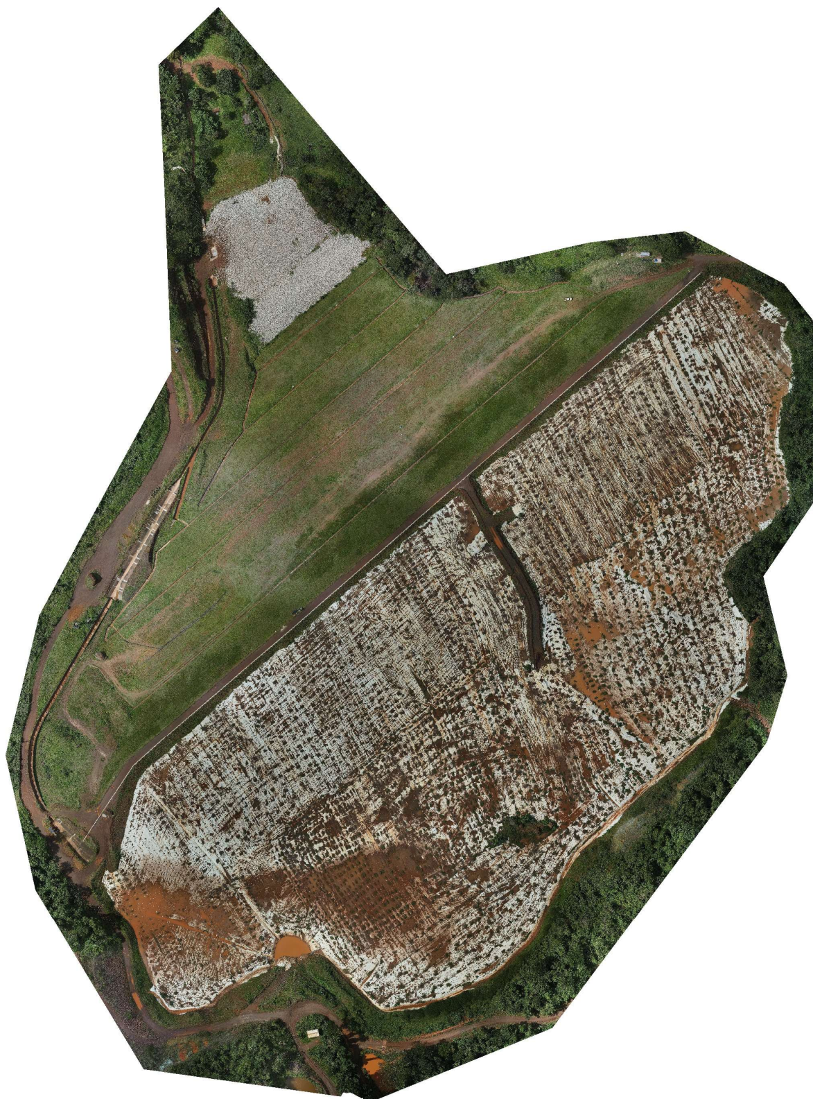
Figura 4.2 – Imagem da Barragem B1-Auxiliar – Mina Tico-Tico. (Fonte: Ortofoto MMI – Janeiro/2025).
