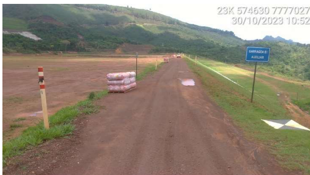
Foto 5.3 – Materiais dispostos na crista da estrutura.
