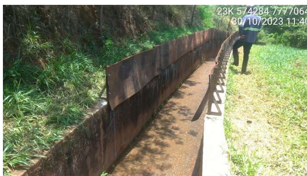
Foto 5.5 – Detalhe da adequação do canal extravasador.
