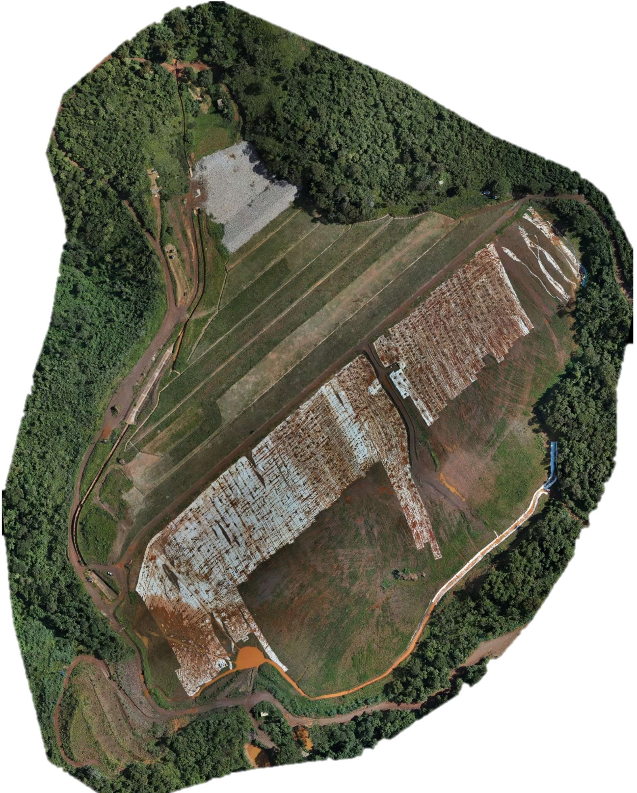
Figura 4.2 – Imagem da Barragem B1-Auxiliar – Mina Tico-Tico. (Fonte: Ortofoto MMI – Março/2024).
