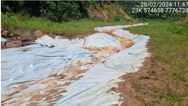
Foto 5.3 – Impermeabilização do canal de cintura. Foto 5.4 – Impermeabilização do canal de cintura.
