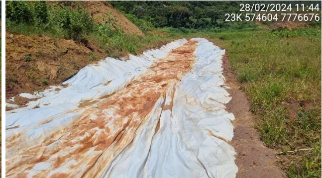
Foto 5.3 – Impermeabilização do canal de cintura. Foto 5.4 – Impermeabilização do canal de cintura.
