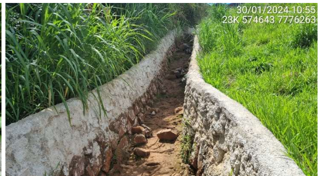
Foto 5.2 – Detalhe do alteamento das paredes do canal extravisor de emergência.
