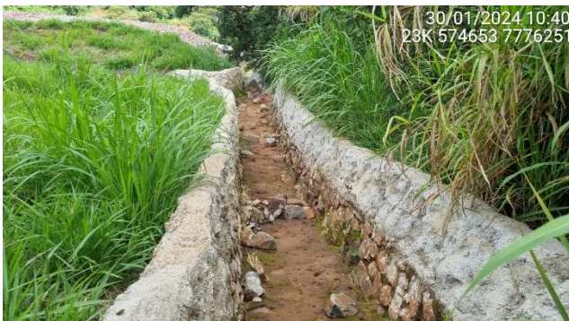
Foto 5.1 – Detalhe do alteamento das paredes do canal extravisor de emergência.
