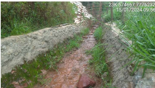
Foto 5.7 – Canal extravasor desobstruído na região da estrutura de contenção.
