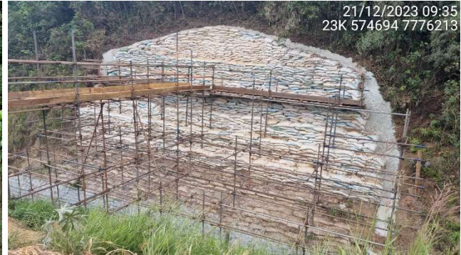
Foto 5.4 – Conclusão da contenção em sacaria de solo-cimento.
