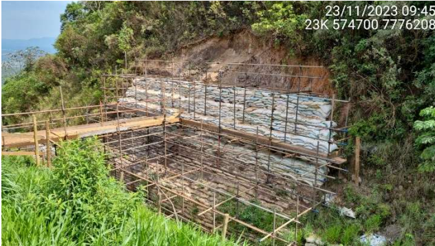
Foto 5.3 – Execução de estrutura de contenção no talude instável na ombreira direita.
