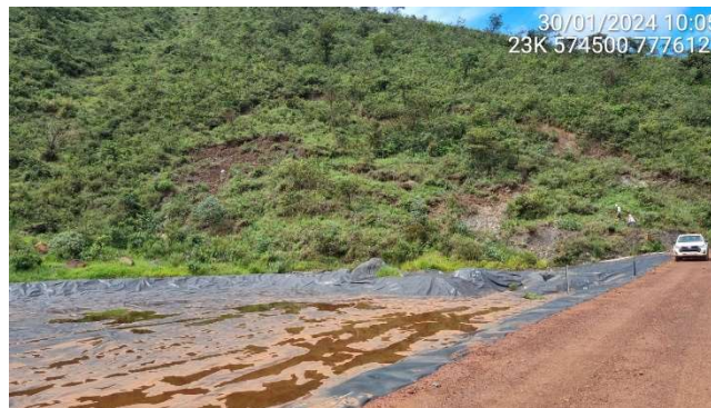
Figura 5.9 – Vista da encosta na margem esquerda do reservatório a ser estabilizada.
