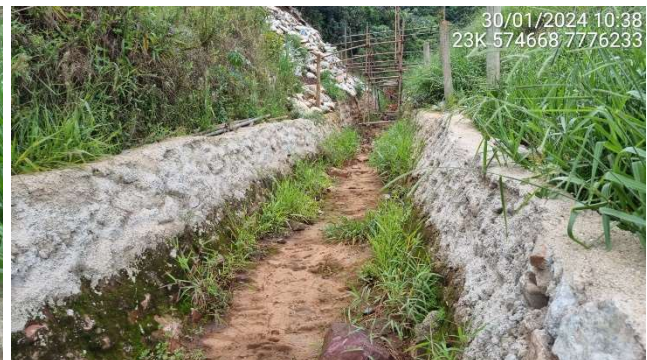
Foto 5.8 – Canal extravasor desobstruído na região da estrutura de contenção.
