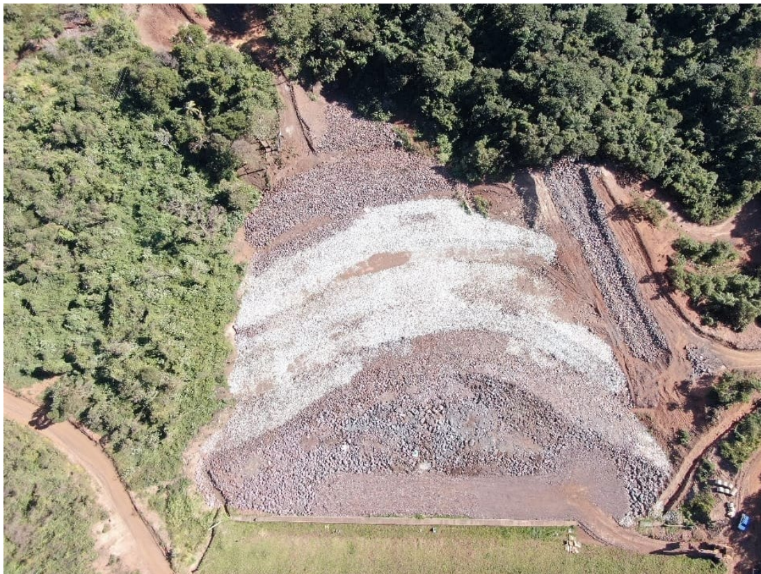
Figura 8. Ampliação do reforço.
