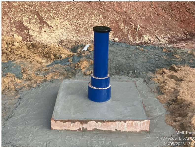
Figura 11. Poço perfurado à jusante da barragem B2 Tico-Tico.
