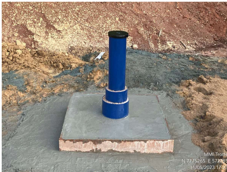
Figura 6. Poço perfurado à jusante da barragem B2 Tico-Tico.
