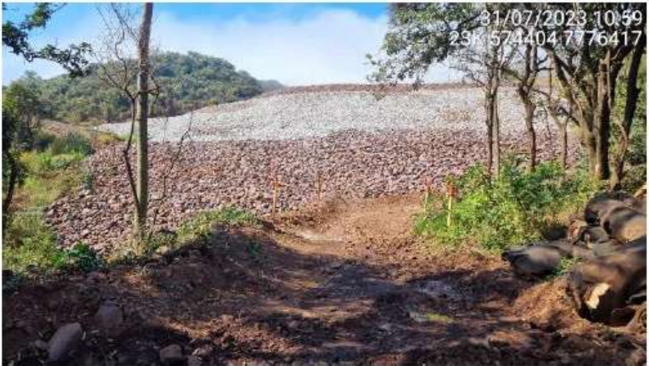
Figura 4. Vista dos taludes de jusante, estrutura de reforço.
