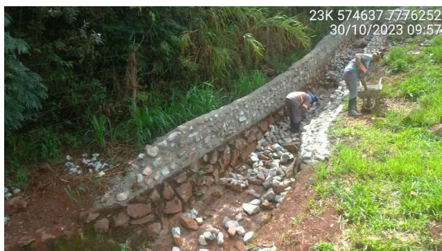
Foto 5.1 – Execução da adequação do canal extravasor
