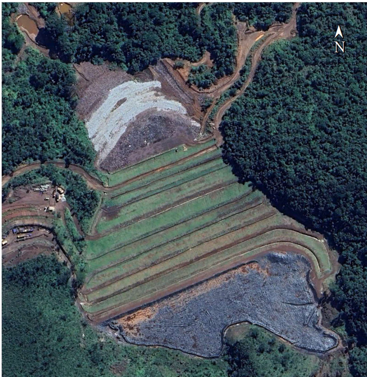
Figura 4.2 – Imagem da Barragem B2 – Mina Tico-Tico. (Fonte: GoogleEarth® - Maio/2023).
