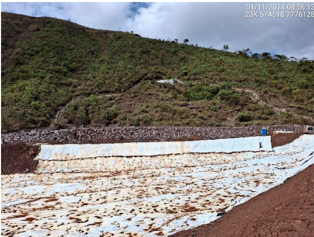
Foto 6.1 – Revestimento do reservatório com lona de Polietileno de Baixa Densidade.
