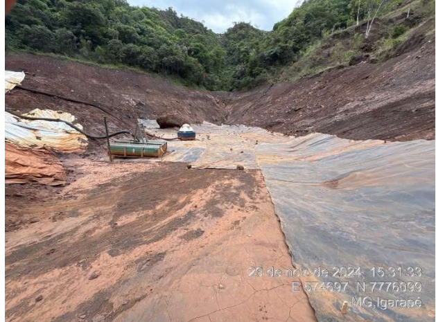
Foto 6.12 – Revestimento parcial do sump do reservatório com geomembrana de PEAD.
