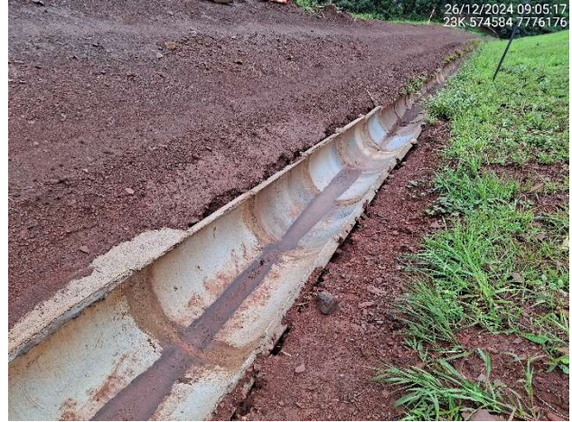
Foto 6.64 – Parte do dispositivo de drenagem da berma 1.119,0m reconstruído.
