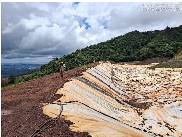
Foto 6.17 – Execução de reparo no revestimento de lona PEBD na face do talude de montante.
