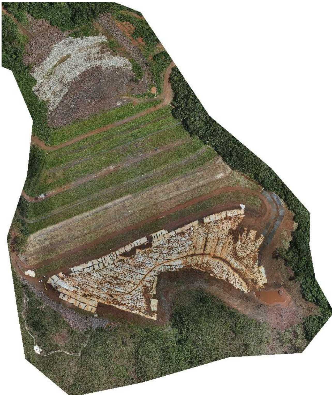
Figura 4.2 – Imagem da Barragem B2 – Mina Tico-Tico. (Fonte: Ortofoto MMI – Janeiro/2025).
