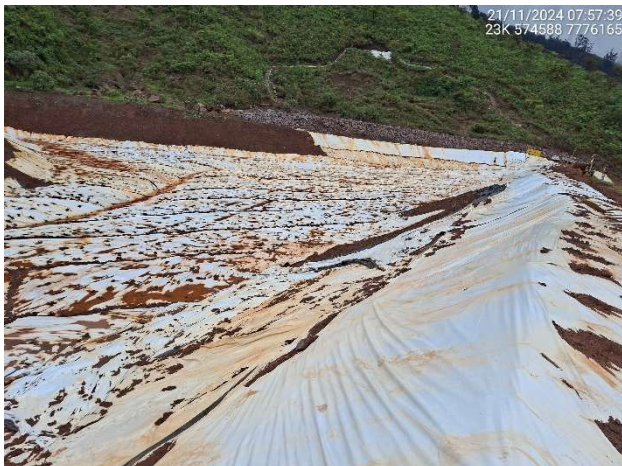
Foto 6.5 – Revestimento do reservatório com lona de Polietileno de Baixa Densidade.
