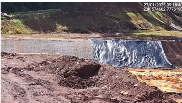
Foto 6.67 – Proteção na região em que foi verificada erosão na face do talude de montante.
