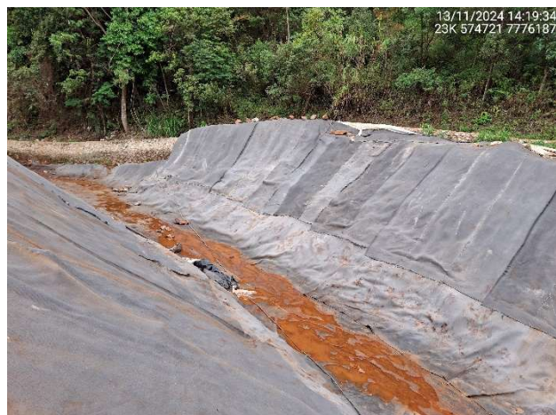
Foto 6.10 – Revestimento com manta cimentícia dos taludes do canal de conexão.
