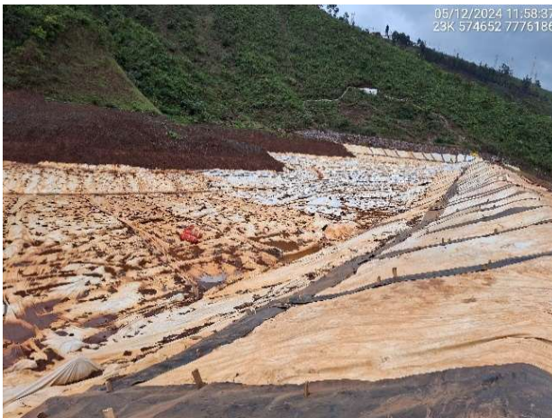
Foto 6.13 – Execução de reparo no revestimento de lona PEBD na face do talude de montante.
