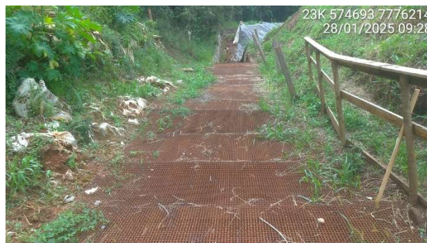
Foto 5.6 – Grades metálicas instaladas sobre o canal extravasador de emergência.
