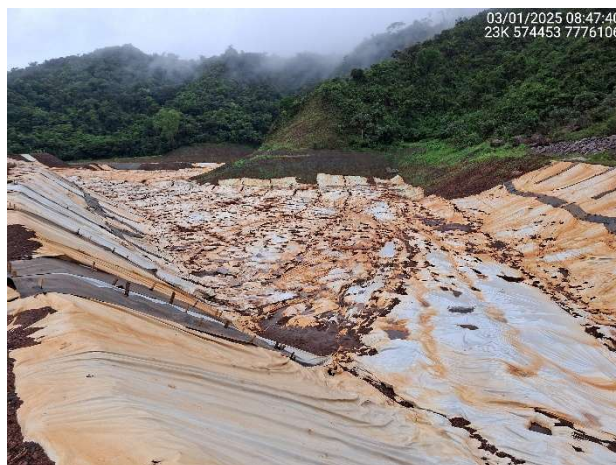
Foto 6.18 – Visão geral do reservatório da Barragem B2 – Mina Tico-Tico.
