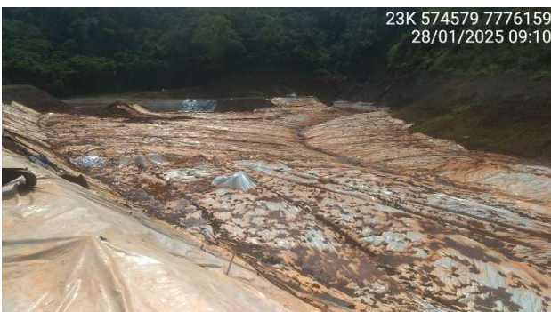
Foto 6.73 – Revestimento do reservatório e face do talude de montante.
