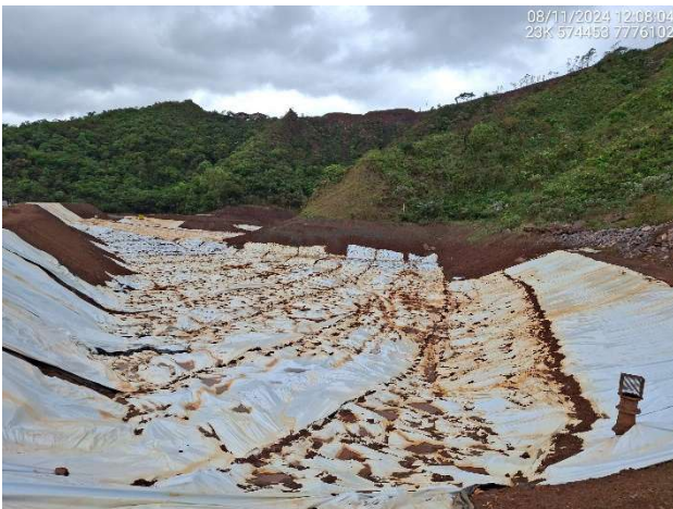
Foto 6.3 – Revestimento do reservatório com lona de Polietileno de Baixa Densidade.
