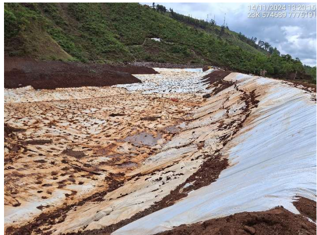
Foto 6.4 – Revestimento do reservatório com lona de Polietileno de Baixa Densidade.
