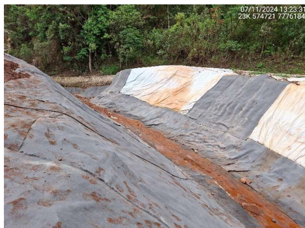
Foto 6.8 – Revestimento com manta cimentícia dos taludes do canal de conexão.
