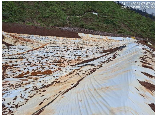
Foto 6.6 – Revestimento do reservatório com lona de Polietileno de Baixa Densidade.
