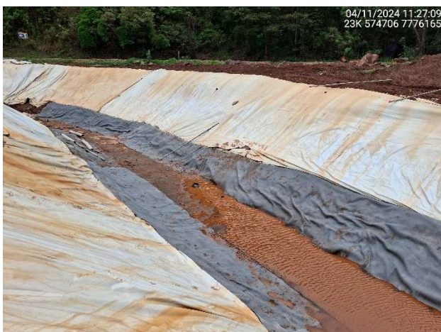
Foto 6.7 – Revestimento com manta cimentícia dos taludes do canal de conexão.
