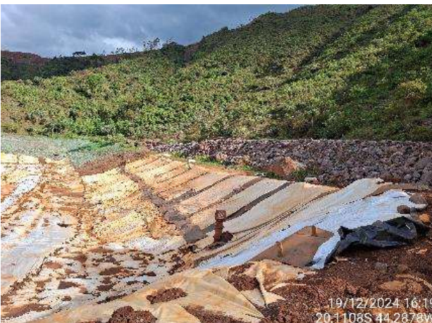
Foto 6.15 – Recomposição das falhas no revestimento em PEBD no reservatório.
