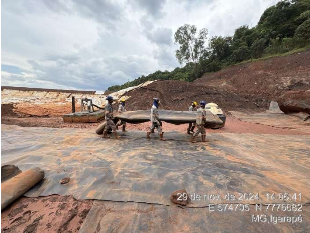
Foto 6.11 – Revestimento parcial do sump do reservatório com geomembrana de PEAD.
