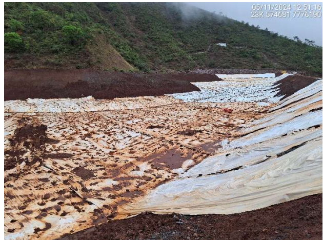
Foto 6.2 – Revestimento do reservatório com lona de Polietileno de Baixa Densidade.
