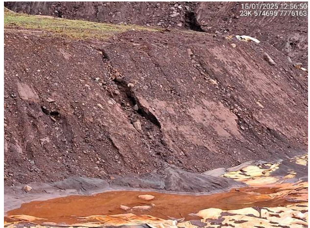
Foto 6.66 – Erosão na face do talude de montante.
