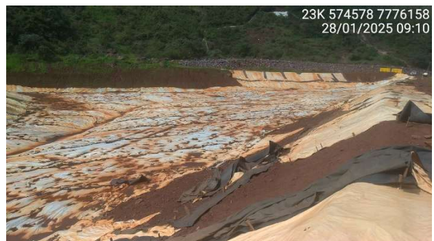
Foto 6.74 – Revestimento do reservatório e face do talude de montante.
