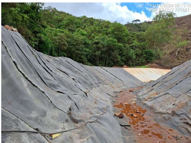
Foto 6.9 – Revestimento com manta cimentícia dos taludes do canal de conexão.
