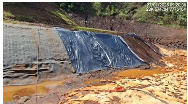
Foto 6.68 – Proteção na região em que foi verificada erosão na face do talude de montante.
