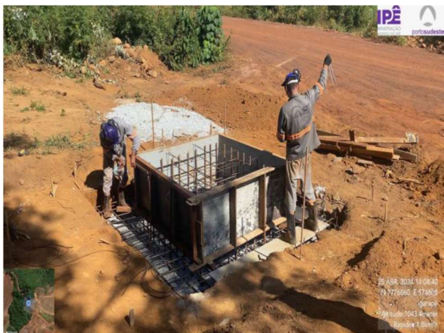
Foto 5.3 – Execução da base da caixa d'água.
