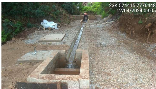
Foto 5.5 – Canaleta e caixa de passagem para coleta do fluxo da nascente e da drenagem interna.
