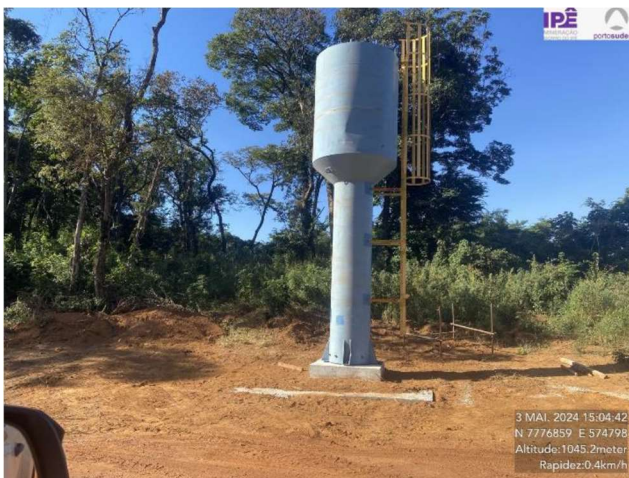
Foto 5.4 – Caixa d'água (taça) fixada à base.
