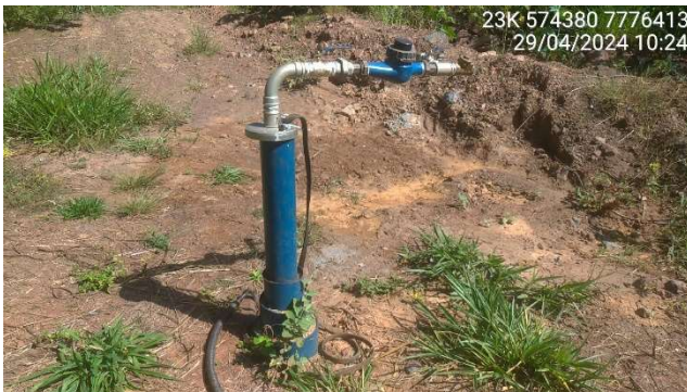
Foto 5.1 – Vista do poço de bombeamento PT-03.
