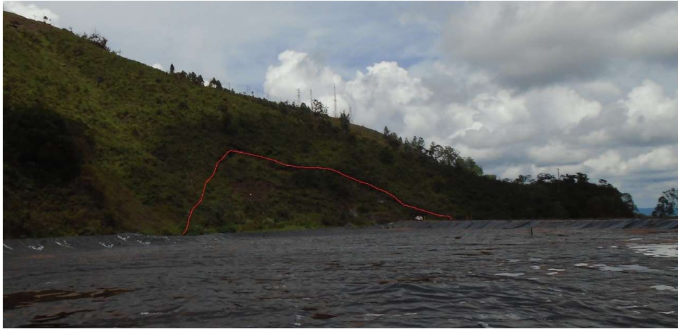
Figura 5.9 – Vista do escorregamento situado na encosta a montante do reservatório.
