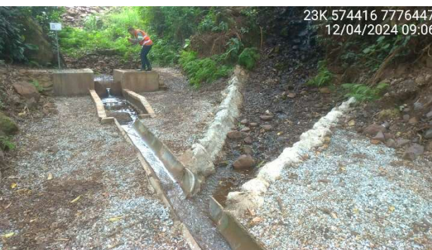
Foto 5.6 – Coleta dos fluxos da nascente na ombreira esquerda e da drenagem interna.
