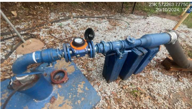
Foto 5.3 – Vista do poço – PT-02.
