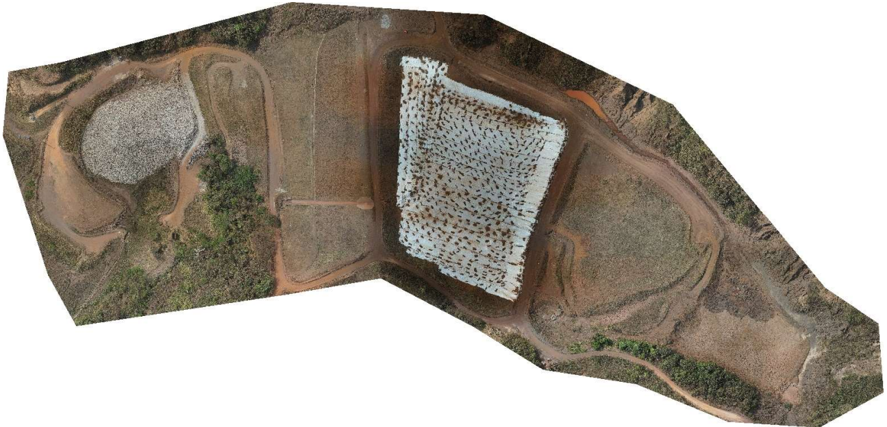
Figura 4.2 – Imagem da Barragem B1 – Mina Ipê. (Fonte: Ortofoto MMI – Setembro/2024).
