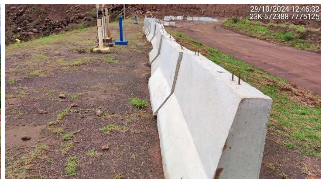
Foto 5.14 – Detalhe da barreira New Jersey .
