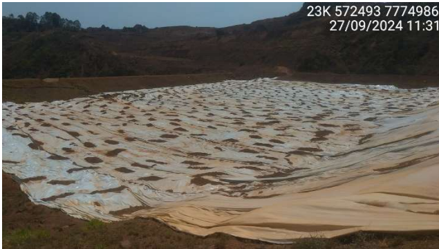
Foto 5.11 – Baía de jusante impermeabilizada.
