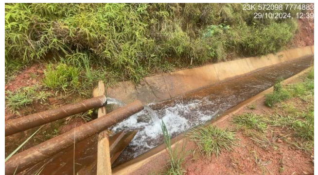
Foto 5.4 – Vista do direcionamento do fluxo dos poços para o extravasor da Barragem B1A Emicon.
