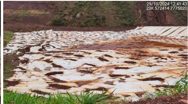
Foto 5.12 – Baía de jusante impermeabilizada.
