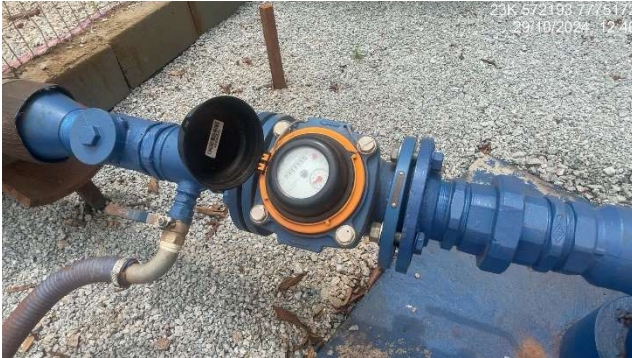
Foto 5.1 – Vista do poço de bombeamento PT-01.
