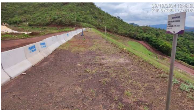
Foto 5.13 – Vista da crista com a implantação das barreiras New Jersey .
