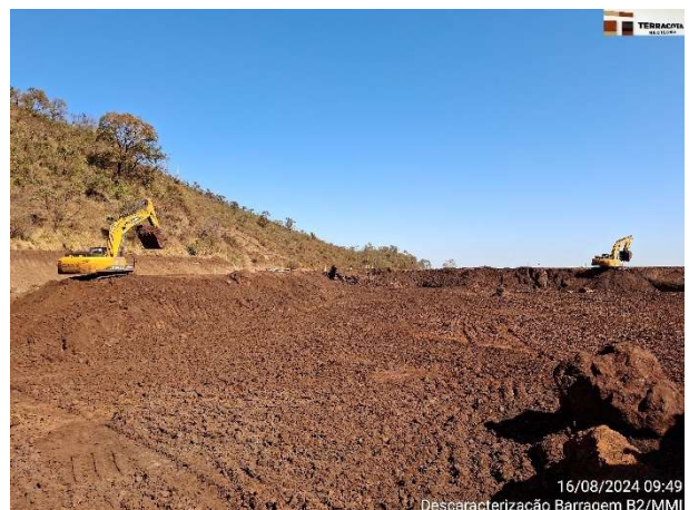
Foto 6.8 – Escavação do rejeito do reservatório – Etapa 1 – Fase 1C.
