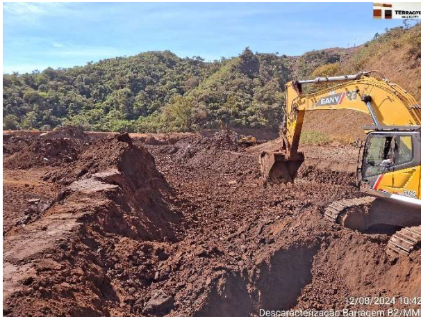
Foto 6.5 – Escavação do rejeito do reservatório – Etapa 1 – Fase 1C.
