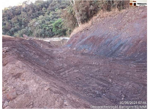
Foto 6.22 – Canal de aproximação do sistema extravasor de emergência - Etapa 1 – Fase 1.
