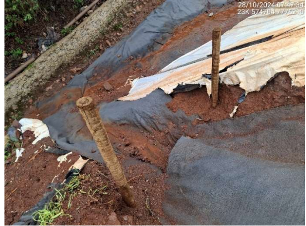
Foto 6.80 – Instalada manta cimentícia no deságue da drenagem superficial.
