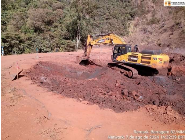
Foto 6.1 – Escavação do rejeito do reservatório – Etapa 1 – Fase 1B.
