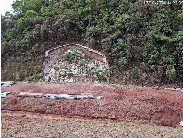
Foto 5.5 – Remoção dos andaimes no canal extravasor próximo à encosta da ombreira direita.
