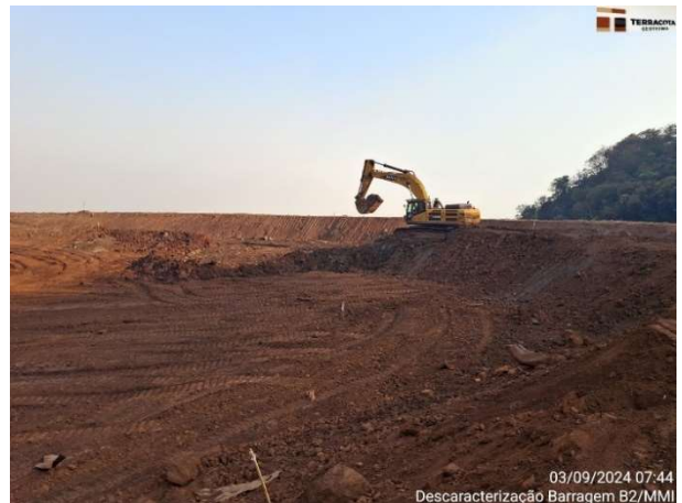
Foto 6.24 – Remoção do maciço do 11º alteamento - Etapa 1 – Fase 1E.
