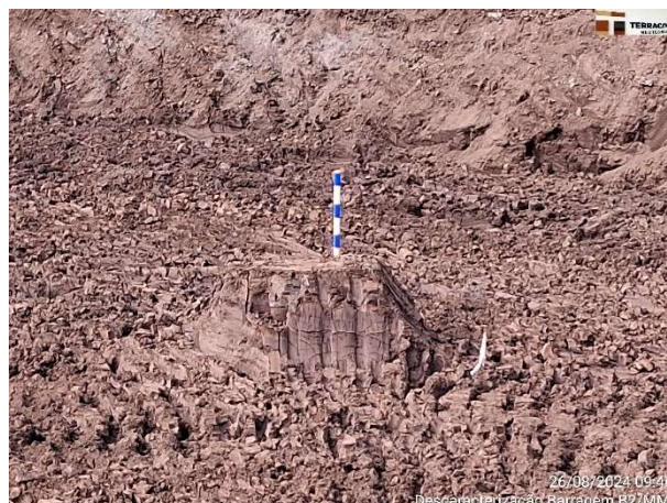
Foto 6.18 – Rebaixamento do instrumento INA-34.
