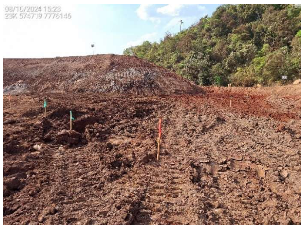
Foto 6.53 – Demarcação da escavação do canal de conexão ao extravaso de emergência.
