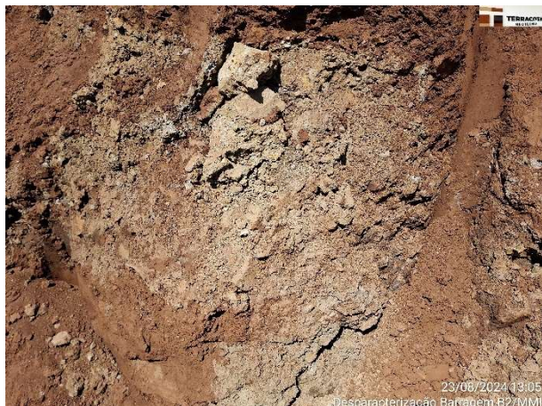
Foto 6.15 – Escavação no contato com a encosta na margem esquerda – Etapa 1 – Fase 1C.
