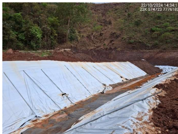
Foto 6.60 – Revestimento do canal com PEBD (taludes) e manta cimentícia (base).
