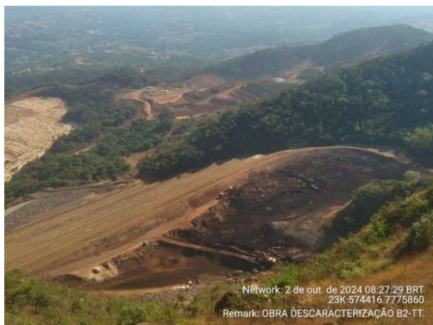
Foto 6.33 – Vista aérea da escavação do reservatório Etapa 1 - Fase 2A.
