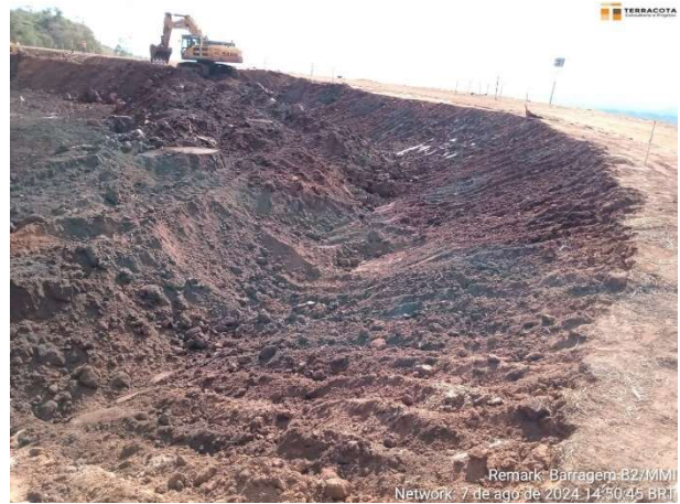
Foto 6.2 – Escavação do rejeito no contato com o talude de montante – Etapa 1 – Fase 1B.
