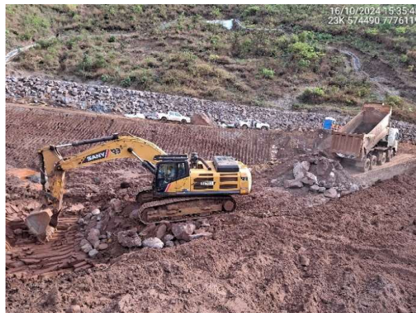
Foto 6.52 – Execução de lastro no reservatório para acesso de caminhões e equipamentos.
