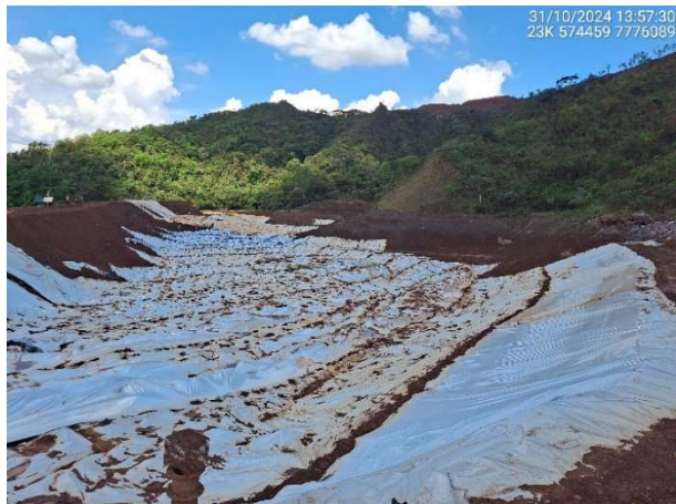
Foto 6.69 – Revestimento do reservatório e face do talude de montante com PEBD.
