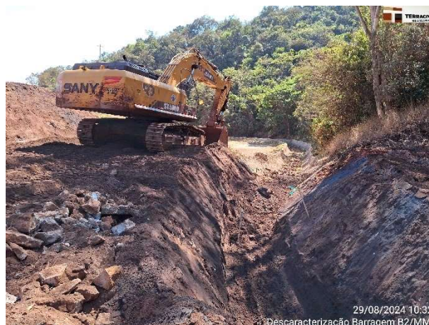
Foto 6.20 – Adequação do canal extravador de emergência - Etapa 1 – Fase 1.
