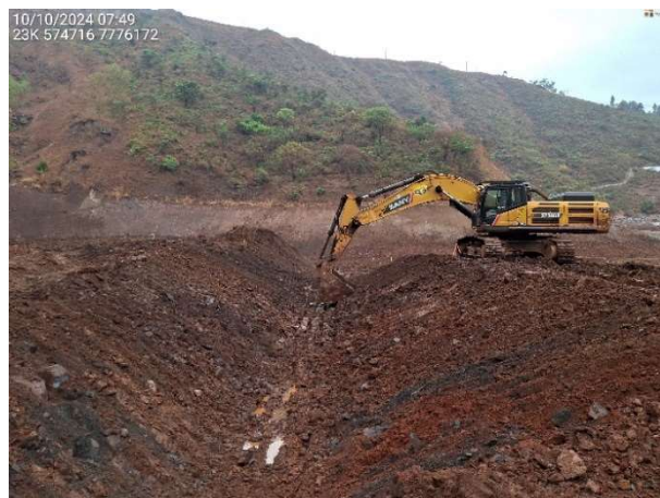
Foto 6.54 – Escavação do canal de conexão ao extravaso de emergência.
