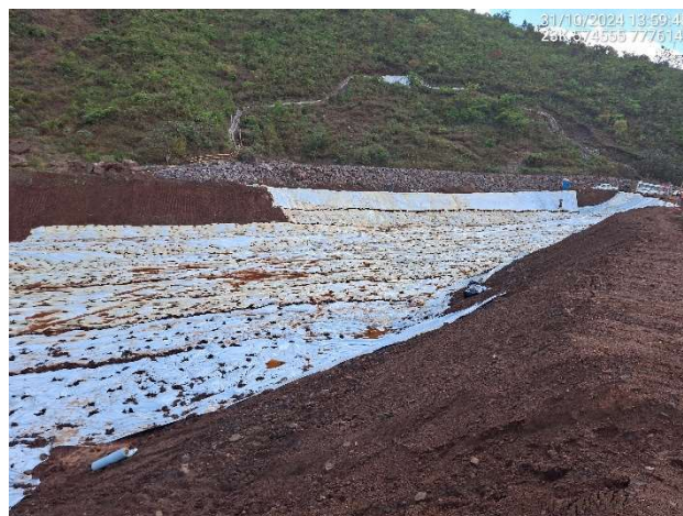
Foto 6.90 – Revestimento do reservatório e face do talude de montante.
