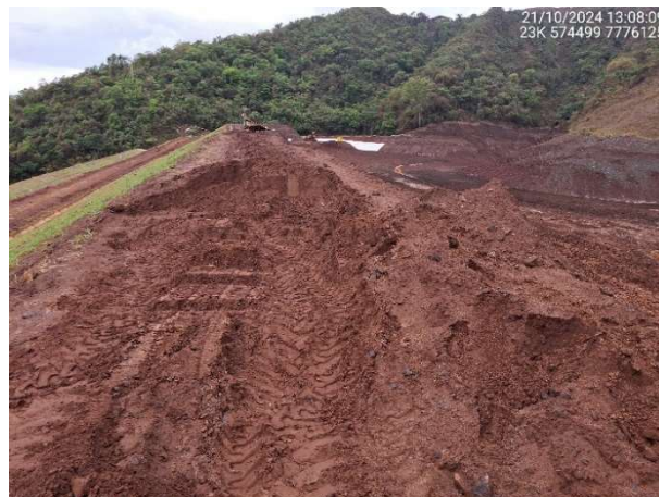
Foto 6.46 – Remoção da leira localizada na crista atual – El. 1.125,0 m.
