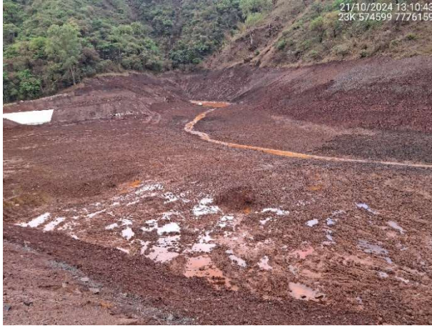
Foto 6.63 – Execução de canal central no reservatório.
