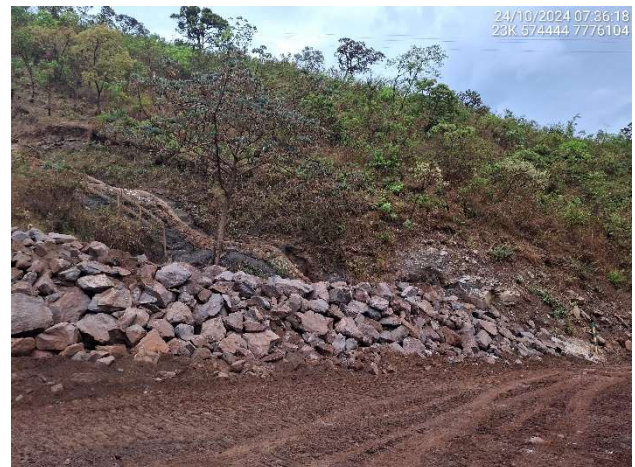
Foto 5.2 – Ampliação da berma de equilíbrio em enrocamento na encosta da ombreira esquerda.
