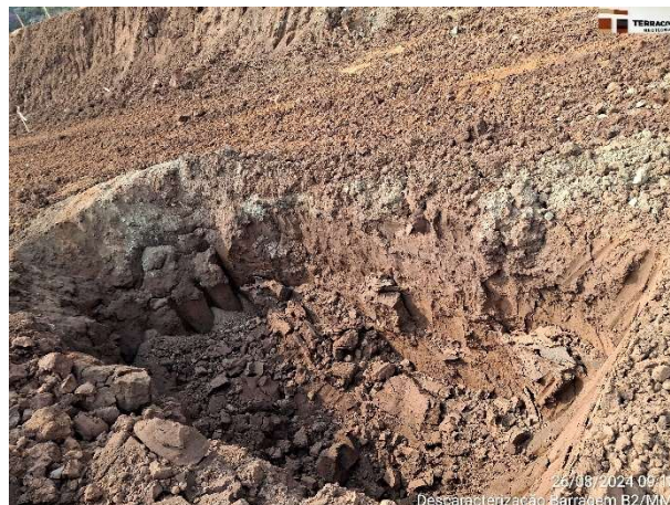
Foto 6.16 – Sondagem na base da escavação no contato com a encosta, com escavadeira.
