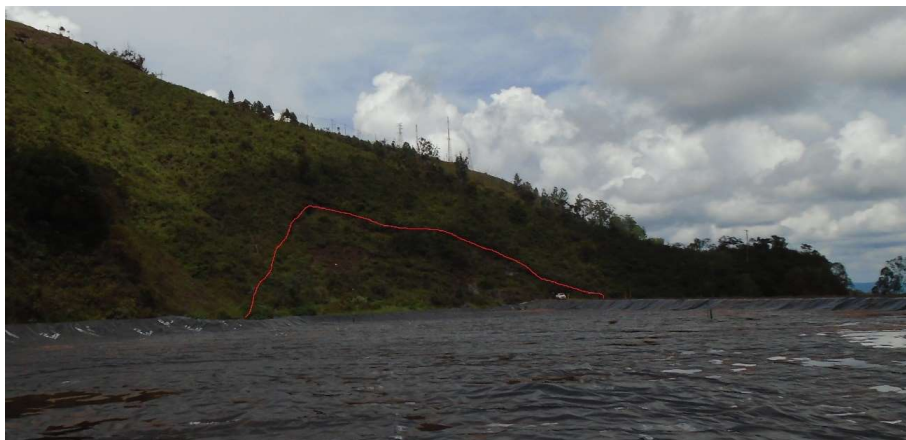
Figura 5.18 – Vista do escorregamento situado na encosta a montante do reservatório.
