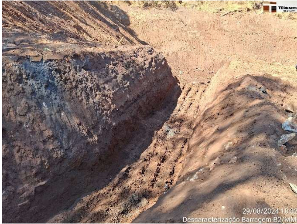
Foto 6.21 – Canal de aproximação do sistema extravasor de emergência - Etapa 1 – Fase 1.
