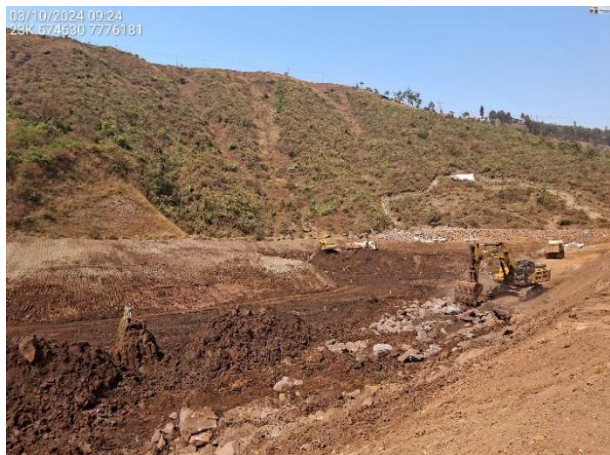
Foto 6.51 – Execução de lastro no reservatório para acesso de caminhões e equipamentos.
