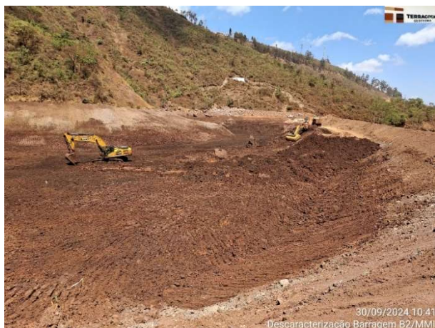
Foto 6.31 – Escavação do rejeito do reservatório referente à Etapa 1 - Fase 2A.
