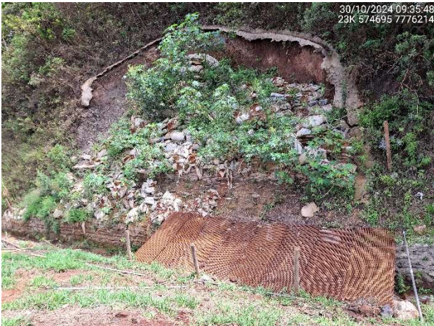
Foto 5.7 – Instalação de grades metálicas sobre o canal extravasor de emergência.
