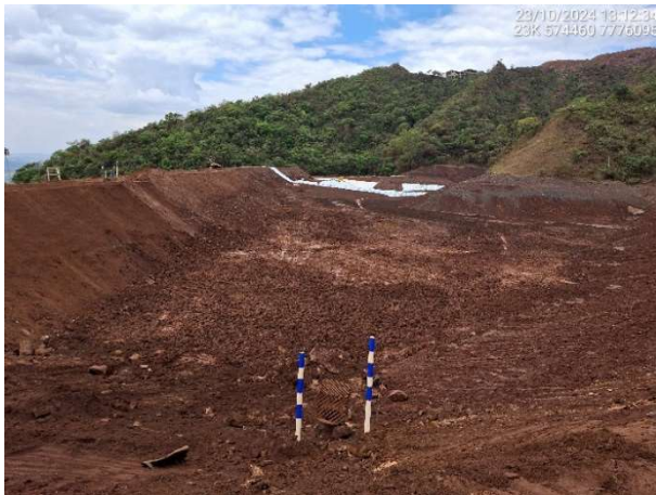
Foto 6.65 – Limpeza no entorno do extravasor operacional.
