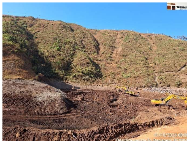
Foto 6.34 – Escavação do rejeito do reservatório referente à Etapa 1 - Fase 2A.
