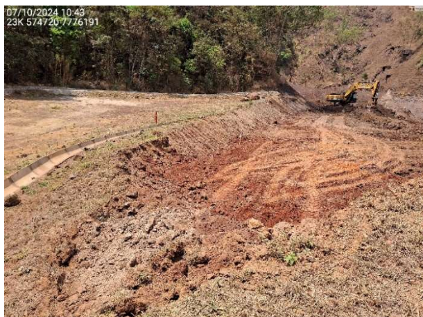
Foto 6.49 – Remoção parcial do maciço do 10º alteamento - Etapa 1 - Fase 2B.
