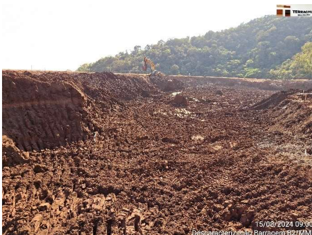
Foto 6.7 – Escavação do rejeito do reservatório – Etapa 1 – Fase 1C.
