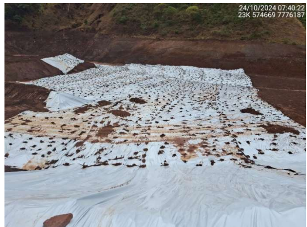
Foto 6.68 – Revestimento do reservatório com lona PEBD (polietileno de baixa densidade).
