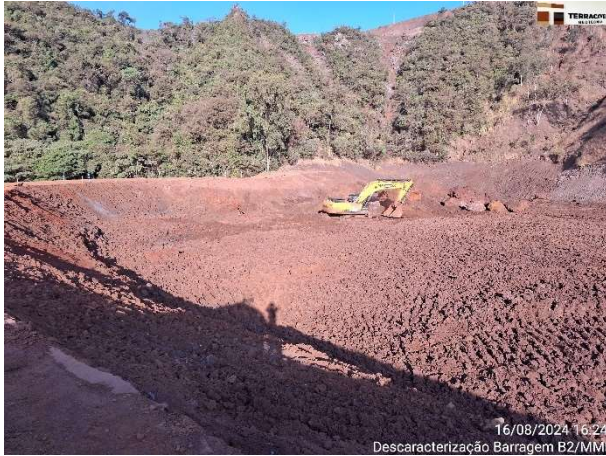
Foto 6.3 – Escavação do rejeito do reservatório – Etapa 1 – Fase 1B.
