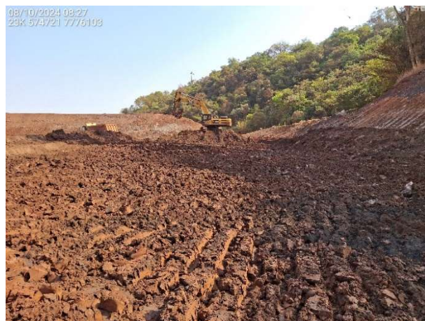
Foto 6.50 – Remoção parcial do maciço do 10º alteamento - Etapa 1 - Fase 2B.
