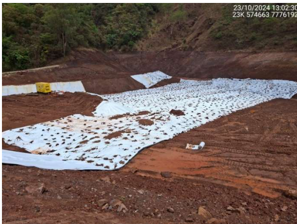
Foto 6.67 – Revestimento do reservatório com lona PEBD (polietileno de baixa densidade).
