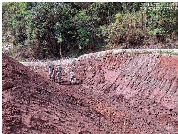
Foto 6.56 – Regularização da escavação do canal de conexão.
