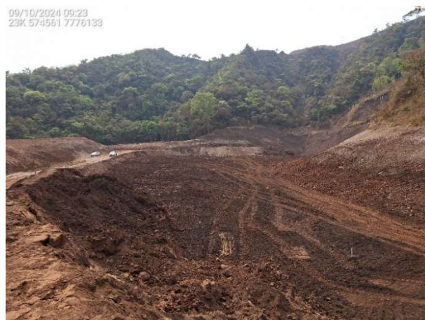
Foto 6.36 – Escavação do rejeito do reservatório referente à Etapa 1 - Fase 2A.
