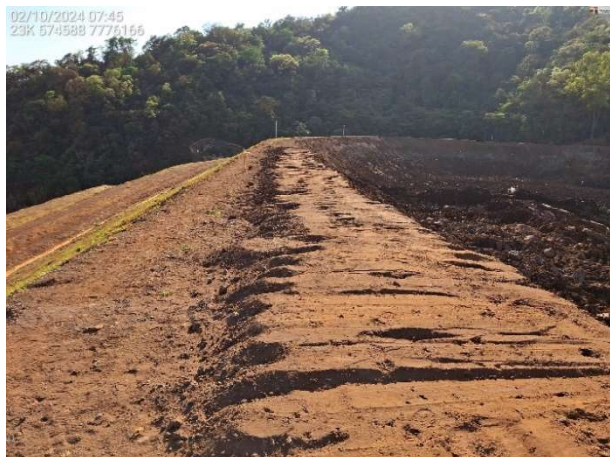
Foto 6.45 – Remoção da leira localizada na crista atual – El. 1.125,0 m.
