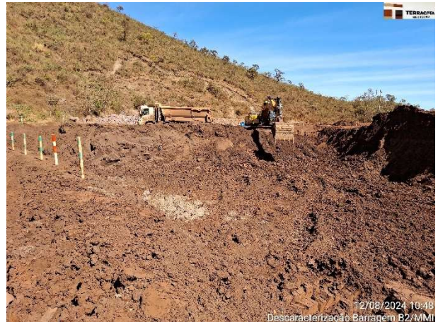
Foto 6.6 – Escavação do rejeito no contato com o talude de montante – Etapa 1 – Fase 1C.
