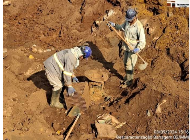
Foto 6.40 – Rebaixamento da tubulação do extravasador operacional.
