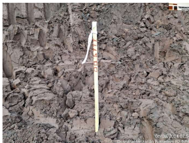
Foto 6.28 – Demarcação para escavação do rejeito do reservatório – Etapa 1 - Fase 2A.
