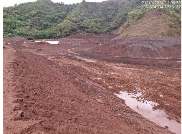
Foto 6.64 – Execução de canal central no reservatório.
