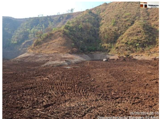
Foto 6.26 – Conclusão da Etapa 1 – Fase 1.
