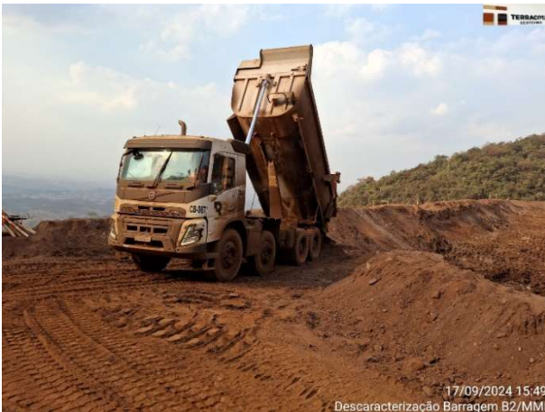
Foto 6.41 – Execução de lastro para acesso ao reservatório e sump.
