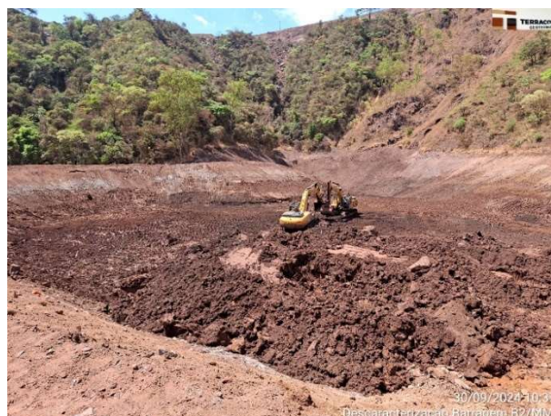
Foto 6.30 – Escavação do rejeito do reservatório referente à Etapa 1 - Fase 2A.
