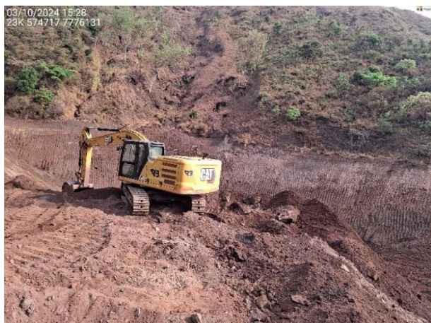
Foto 6.47 – Remoção parcial do maciço do 10º alteamento - Etapa 1 - Fase 2B.
