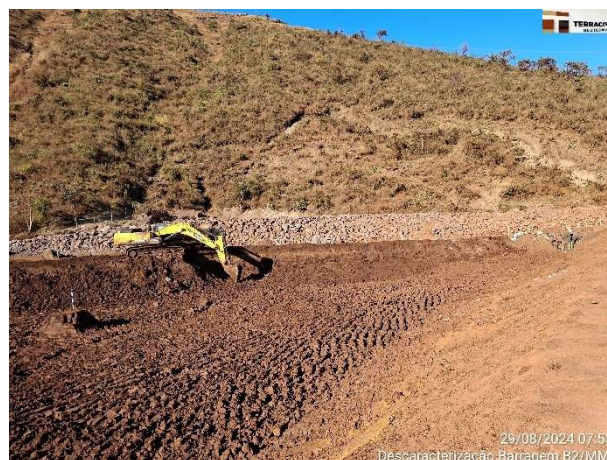
Foto 6.10 – Escavação do rejeito do reservatório – Etapa 1 – Fase 1D.
