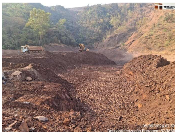
Foto 6.27 – Escavação do rejeito do reservatório – Etapa 1 - Fase 2A (El 1.117,00 m).
