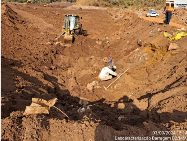
Foto 6.39 – Rebaixamento da tubulação do extravasador operacional.
