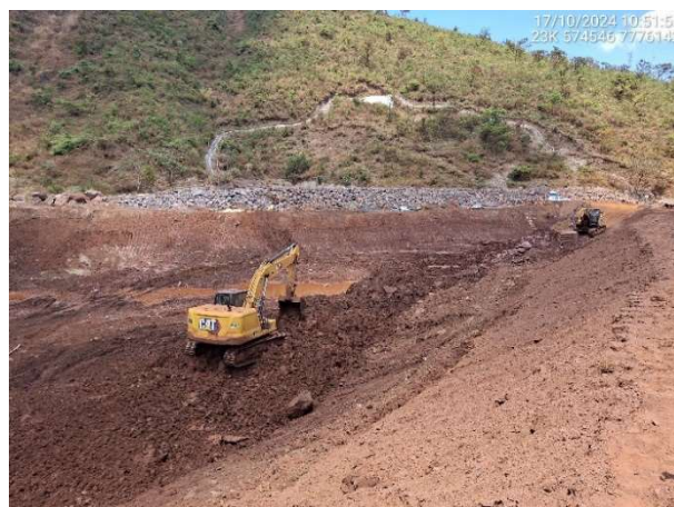
Foto 6.38 – Escavação do rejeito do reservatório referente à Etapa 1 - Fase 2A.
