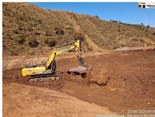
Foto 6.14 – Desmonte dos blocos presentes na base da escavação – Etapa 1 – Fase 1B.
