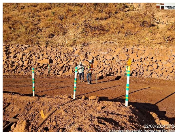
Foto 6.12 – Locação do offset final da Etapa 1 – Fase 1D pela equipe da topografia da MMI.
