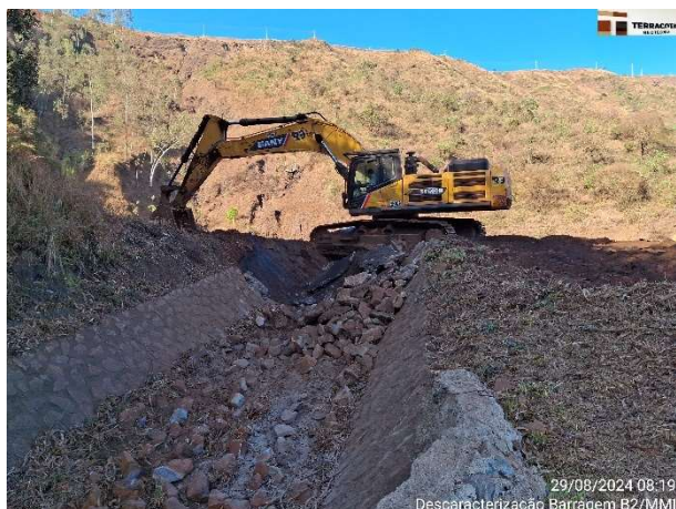
Foto 6.19 – Adequação do canal extravador de emergência - Etapa 1 – Fase 1.
