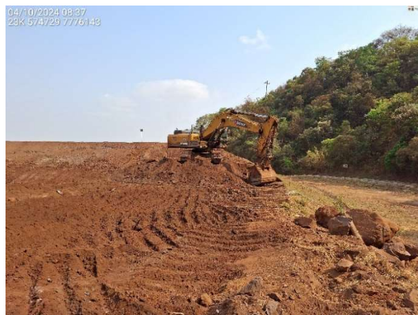
Foto 6.48 – Remoção parcial do maciço do 10º alteamento - Etapa 1 - Fase 2B.
