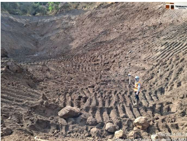
Foto 6.43 – Rebaixamento do sump - Etapa 1 - Fase 2 (Elev. 1.114,00 m ).
