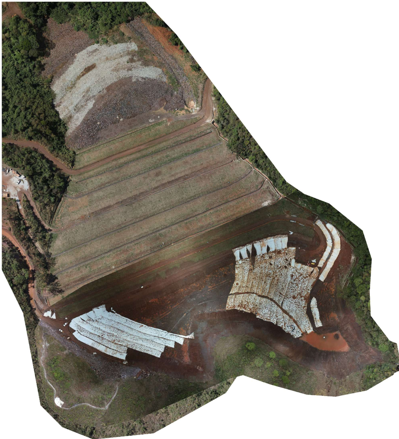
Figura 6.8 –Barragem B2 – Mina Tico-Tico. (Fonte: Ortofoto MMI – outubro/2024).
