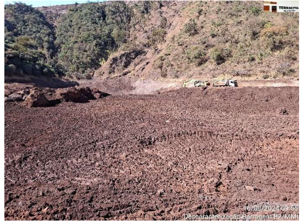
Foto 6.4 – Ajuste na declividade do acesso à crista da barragem.
