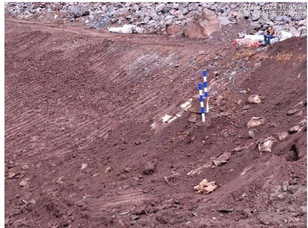
Foto 6.66 – Limpeza no entorno do extravasor operacional.
