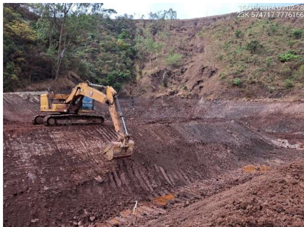
Foto 6.55 – Regularização da escavação do canal de conexão.
