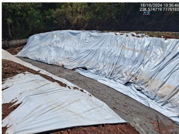
Foto 6.59 – Revestimento do canal com PEBD (taludes) e manta cimentícia (base).
