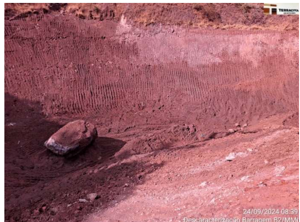
Foto 6.44 – Rebaixamento do sump - Etapa 1 - Fase 2 (Elev. 1.114,00 m ).
