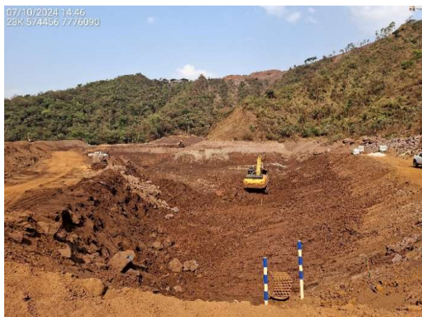
Foto 6.35 – Escavação do rejeito do reservatório referente à Etapa 1 - Fase 2A.
