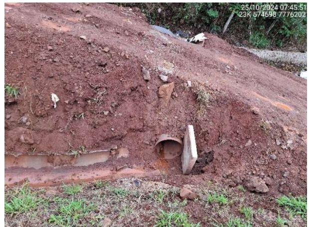
Foto 6.78 – Drenagem superficial da berma El. 1.119,00 desobstruída.
