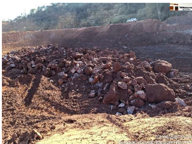
Foto 6.13 – Blocos presentes na base da escavação – Etapa 1 – Fase 1B.
