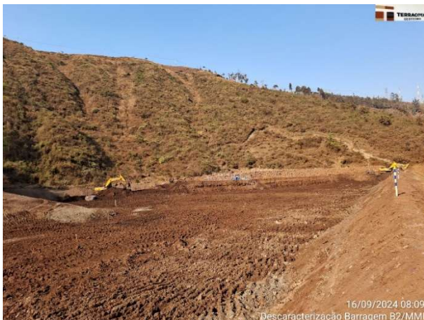
Foto 6.25 – Conclusão da Etapa 1 – Fase 1.
