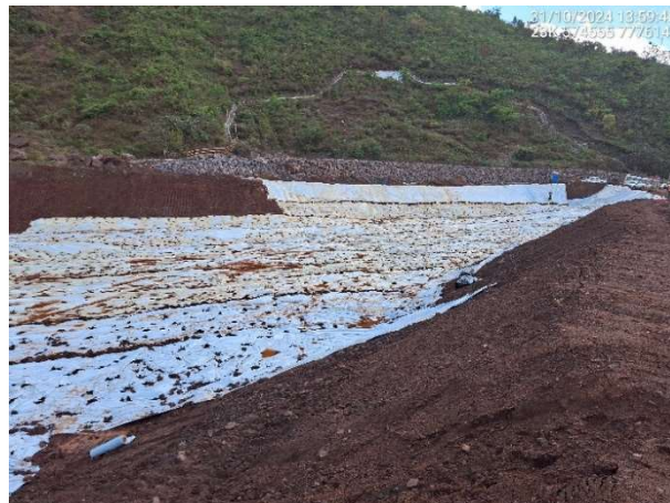
Foto 6.70 – Revestimento do reservatório e face do talude de montante com PEBD.
