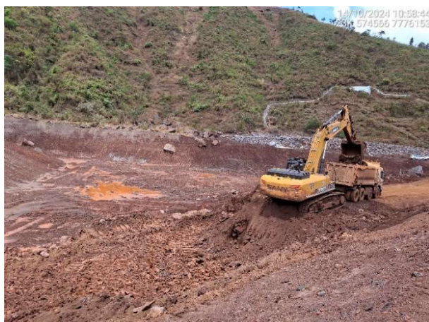
Foto 6.37 – Escavação do rejeito do reservatório referente à Etapa 1 - Fase 2A.
