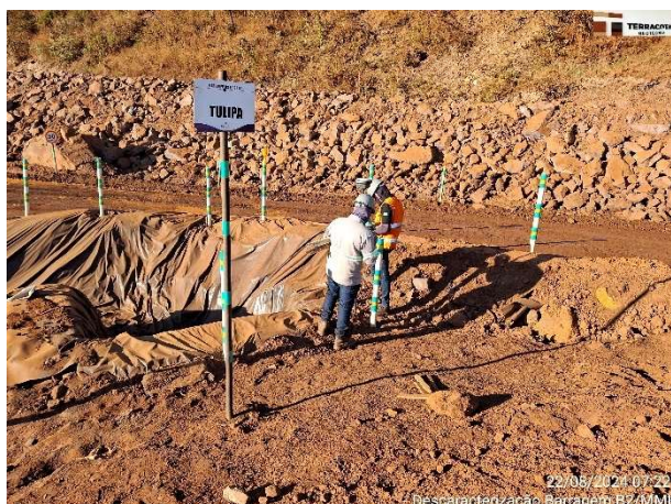
Foto 6.11 – Locação do offset final da Etapa 1 – Fase 1D pela equipe da topografia da MMI.
