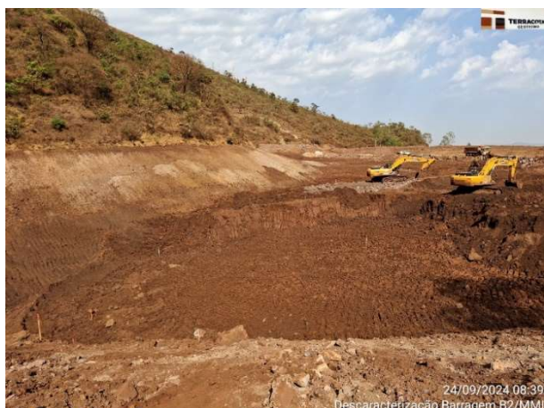
Foto 6.29 – Escavação do rejeito do reservatório referente à Etapa 1 - Fase 2A.
