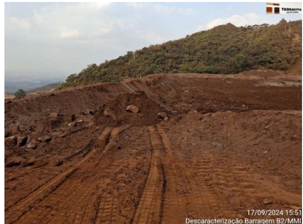
Foto 6.42 – Execução de lastro para acesso ao reservatório e sump.
