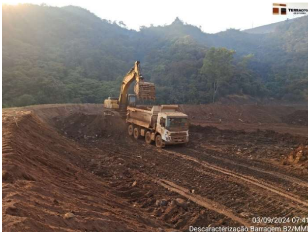
Foto 6.23 – Remoção do maciço do 11º alteamento - Etapa 1 – Fase 1E.
