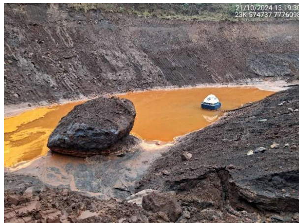
Foto 6.62 – Bomba instalada no sump do reservatório.
