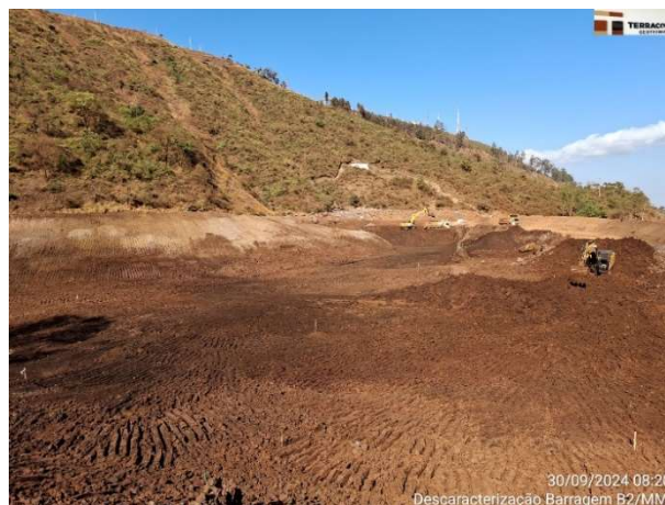
Foto 6.32 – Escavação do rejeito do reservatório referente à Etapa 1 - Fase 2A.
