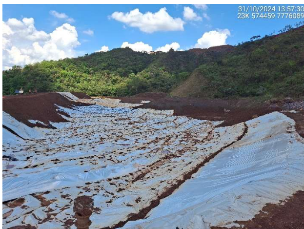
Foto 6.89 – Revestimento do reservatório e face do talude de montante.
