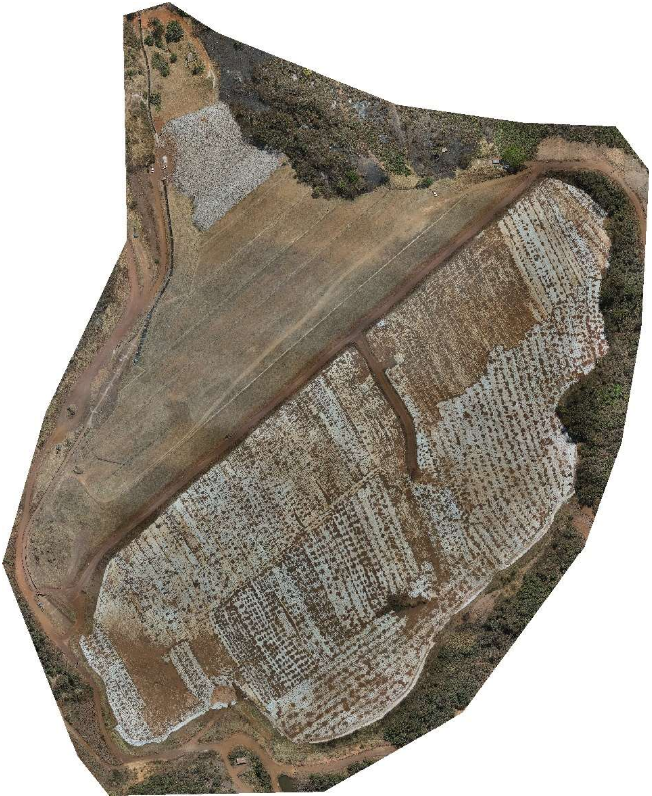
Figura 4.2 – Imagem da Barragem B1-Auxiliar – Mina Tico-Tico. (Fonte: Ortofoto MMI – Setembro/2024).
