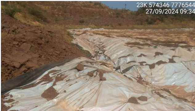
Foto 5.3 – Canal de cintura impermeabilizado.
