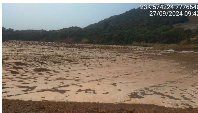
Foto 5.2 – Reservatório impermeabilizado.
