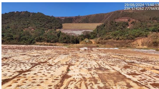
Foto 5.1 – Reservatório impermeabilizado.
