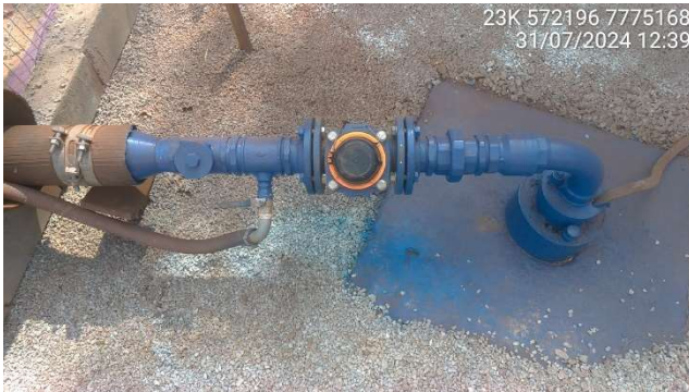
Foto 5.1 – Vista do poço de bombeamento PT-01.
