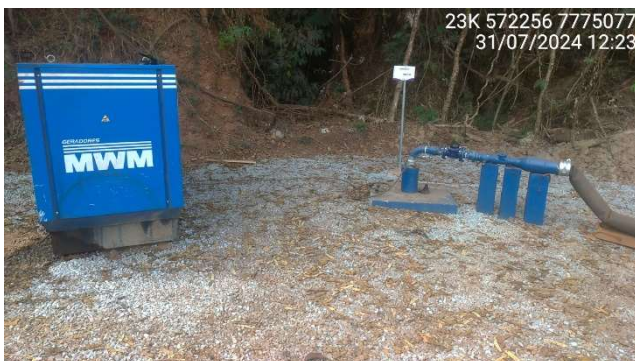
Foto 5.3 – Vista do poço – PT-02.
