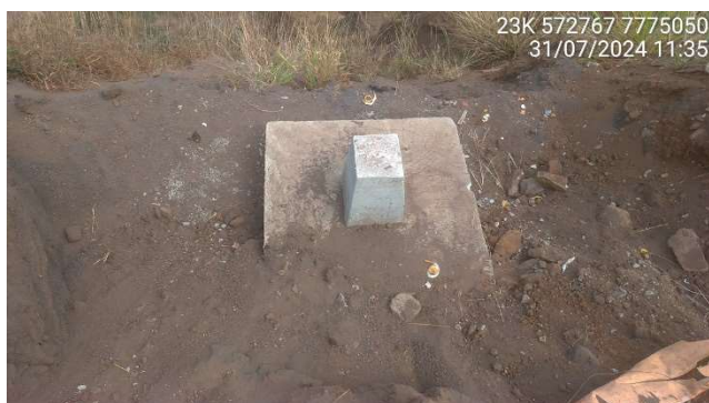
Foto 5.6 – Marco de deslocamento instalado na encosta.
