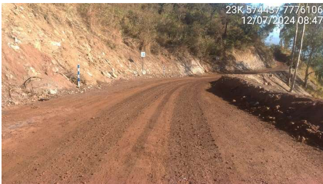
Foto 6.1 – Ajuste na declividade do acesso à crista da barragem.
