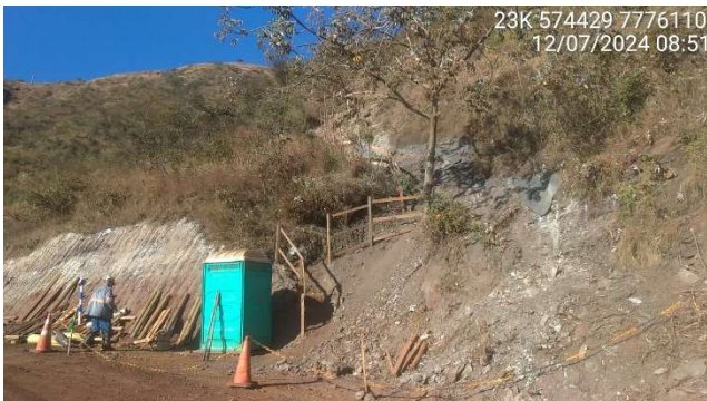
Foto 5.7 – Instalação de dispositivos de drenagem superficial no contato da cunha com o terreno.
