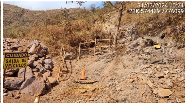
Foto 5.8 – Instalação de dispositivos de drenagem superficial no contato da cunha com o terreno.
