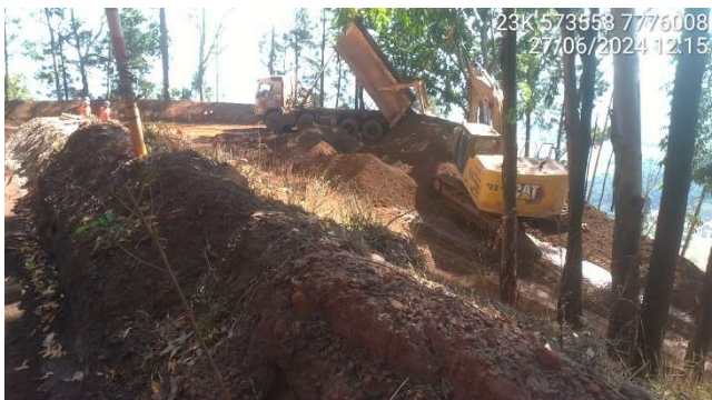
Foto 5.3 – Obra de ajuste da via de acesso à barragem.
