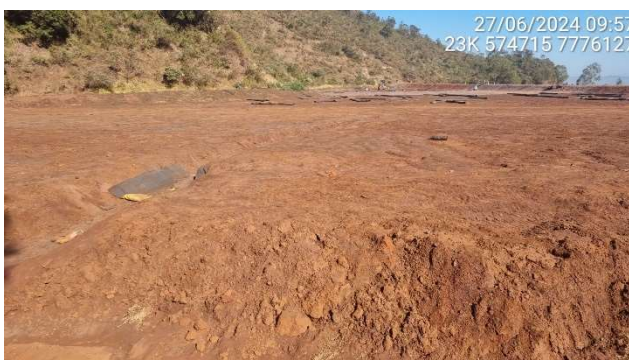
Foto 5.2 – Reservatório da barragem. (Remoção da geomembrana em andamento)
