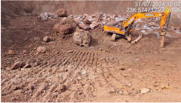
Foto 6.5 – Execução do sump no fundo do reservatório.
