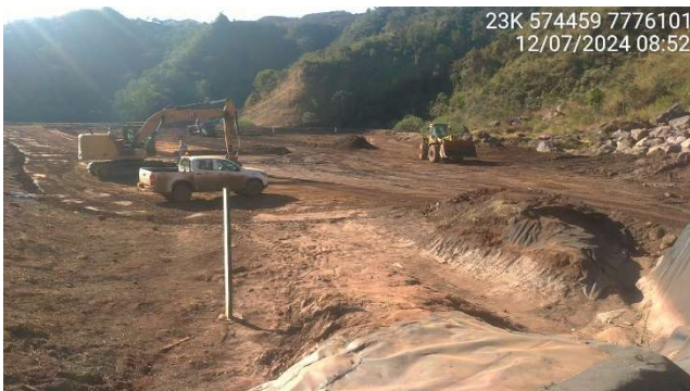
Foto 6.3 – Regularização do reservatório.
