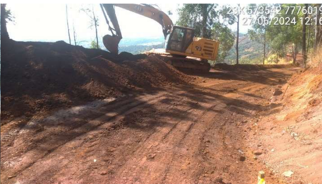
Foto 5.4 – Obra de ajuste da via de acesso à barragem.
