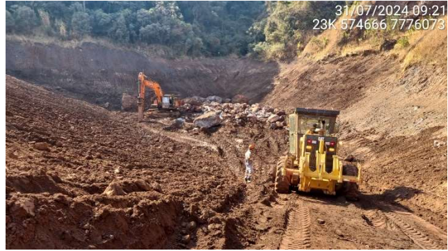
Foto 6.6 – Execução do sump no fundo do reservatório.
