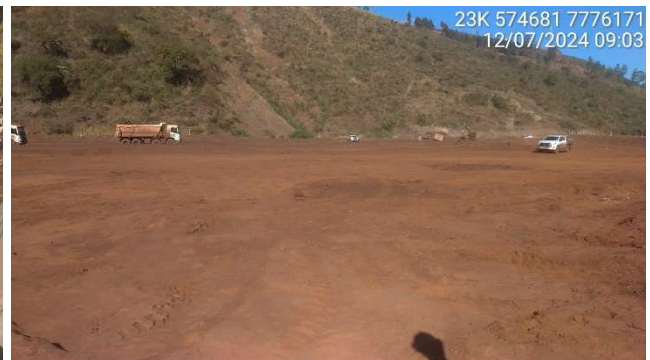
Foto 6.4 – Regularização do reservatório.
