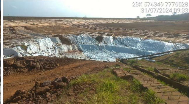
Foto 5.4 – Impermeabilização do sump .
