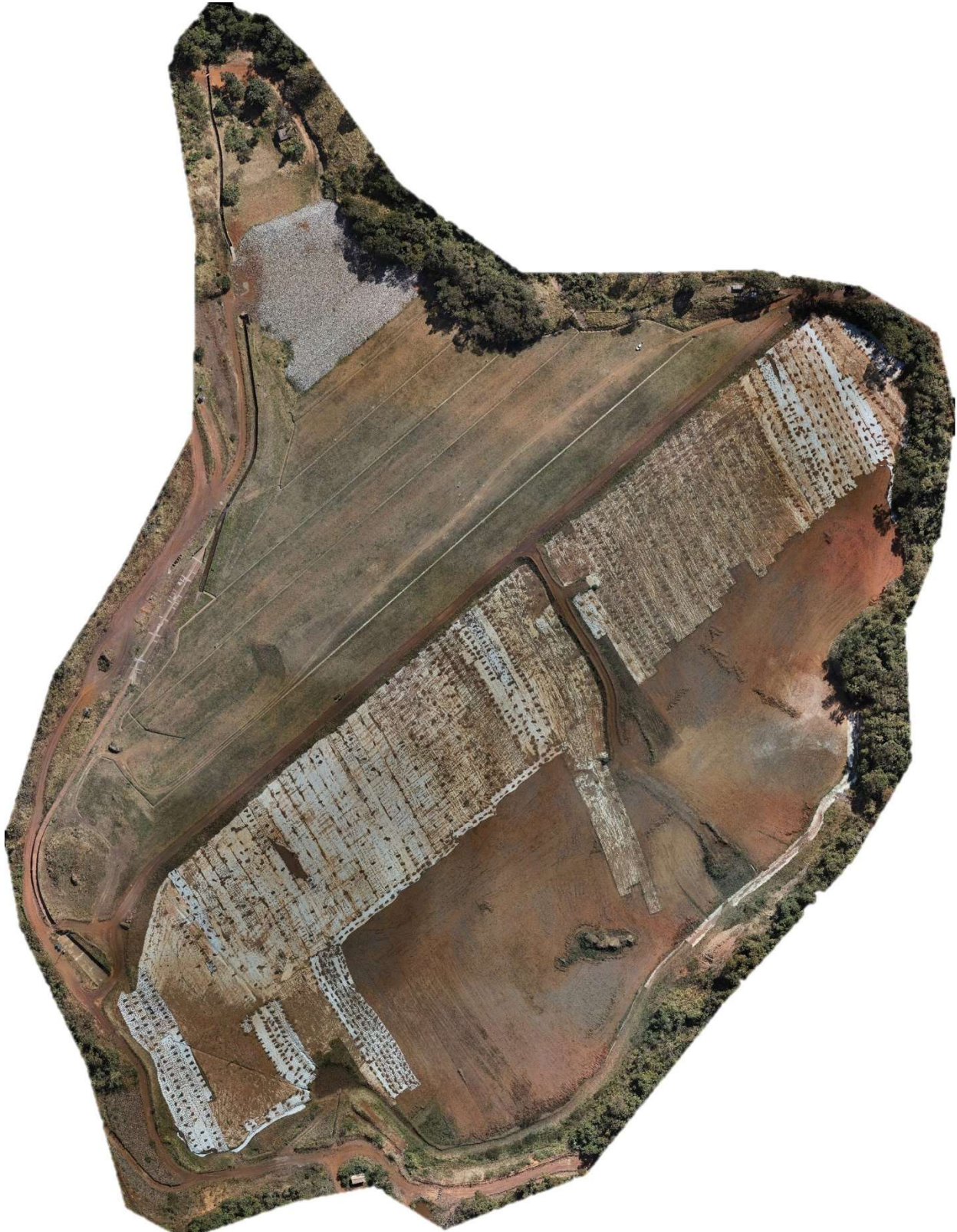
Figura 4.2 – Imagem da Barragem B1-Auxiliar – Mina Tico-Tico. (Fonte: Ortofoto MMI – Julho/2024).
