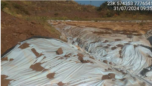
Foto 5.3 – Impermeabilização do canal de cintura.
