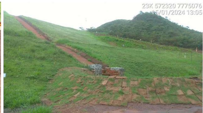
Foto 5.6 – Implantação de revestimento vegetal nas paredes da caixa de dissipação.
