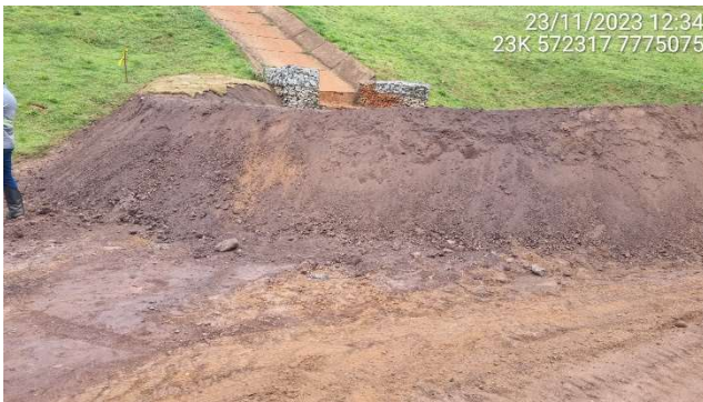
Foto 5.5 – Alteamento das paredes da caixa de dissipação.
