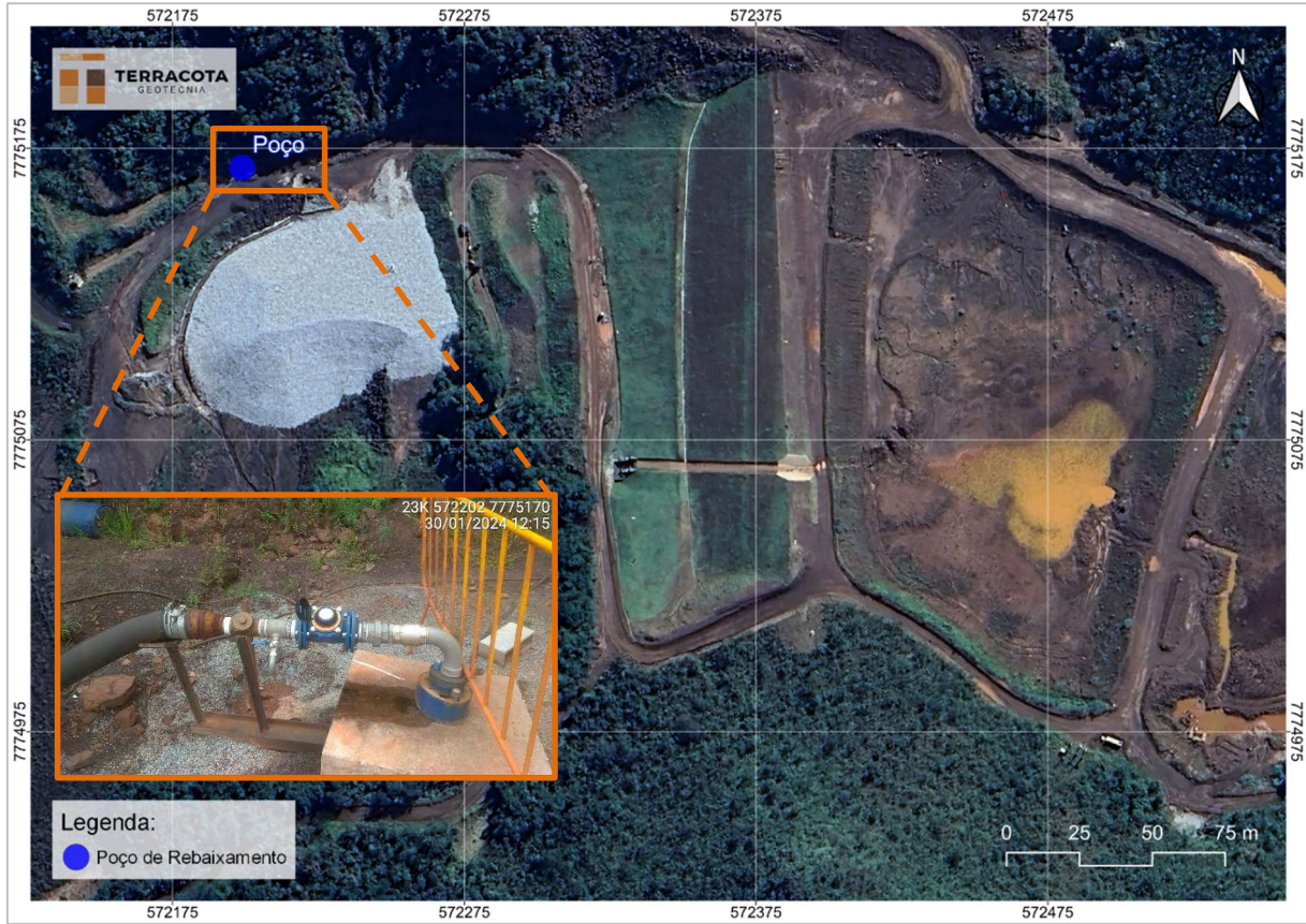
Figura 5.7 – Localização do poço de rebaixamento.
