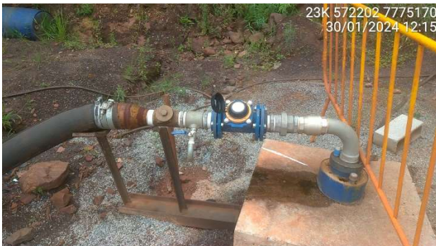
Foto 5.1 – Vista do poço de bombeamento.
