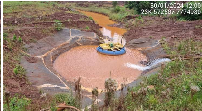
Foto 5.4 – Sistema de bombeamento localizado na baía de montante.
