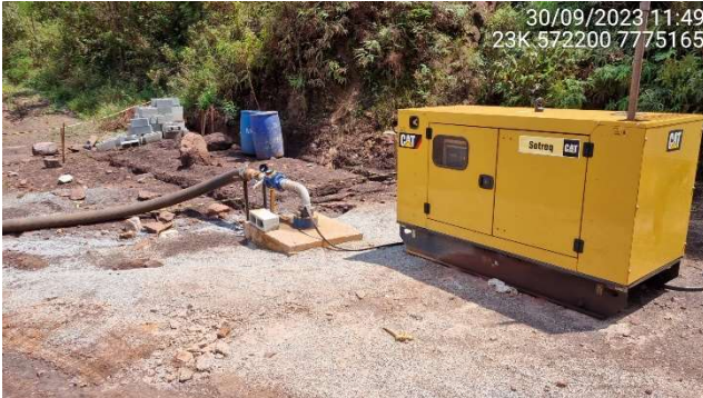
Foto 5.1 – Vista do poço de bombeamento.
