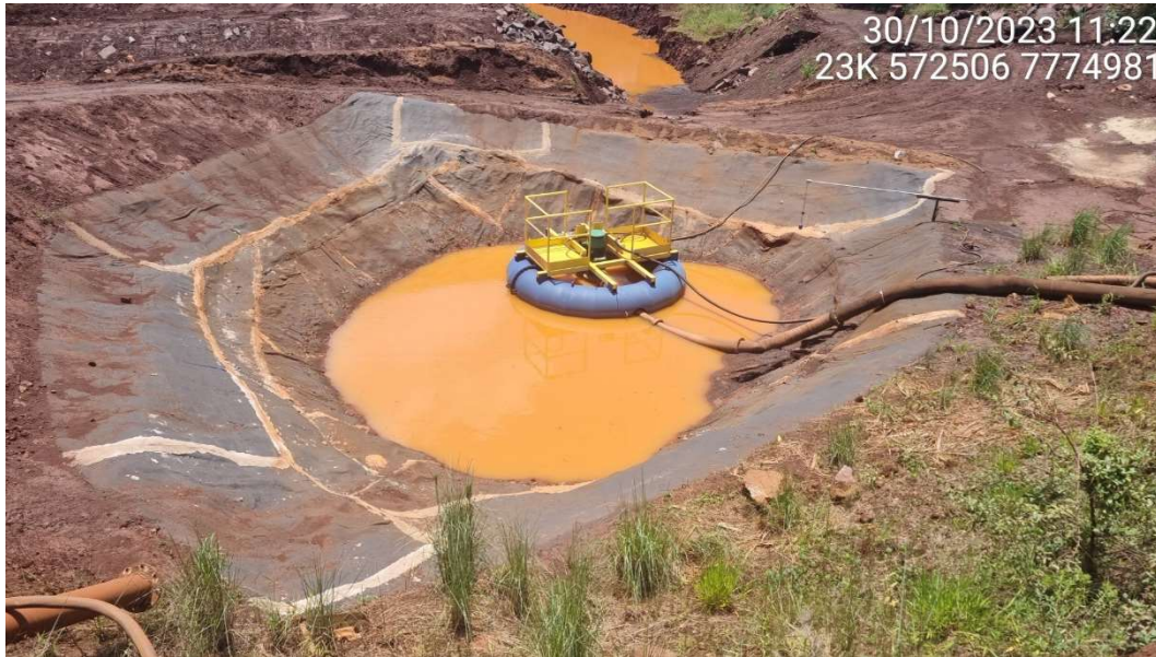
Foto 5.3 – Sistema de bombeamento atual.
