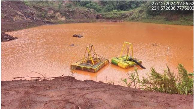
**Foto 5.7** – Sistema de bombeamento localizado na baía de montante.
