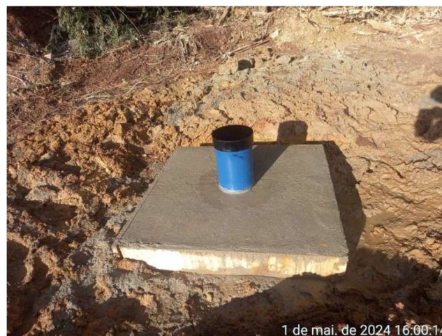
Foto 5.4 – Poço de rebaixamento - PT-02 finalizado.
