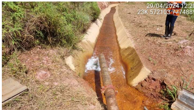
Foto 5.2 – Lançamento da água do poço PT-01 no extravasor de emergência da B1A Emicon.
