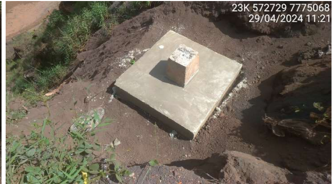
Foto 5.7 – Marco de monitoramento da encosta.
