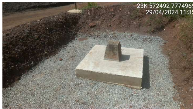
Foto 5.8 – Marco de referência para o monitoramento da encosta.
