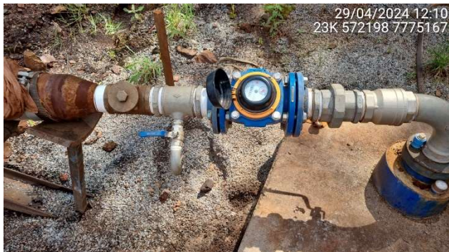
Foto 5.1 – Vista do poço de bombeamento PT-01.
