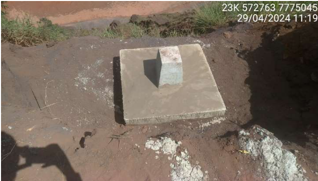
Foto 5.6 – Marco de monitoramento da encosta.
