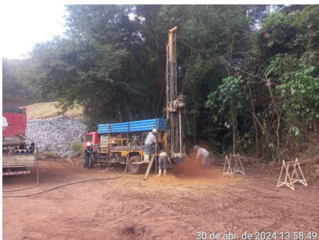
Foto 5.3 – Perfuração do Poço de Rebaixamento - PT-02.
