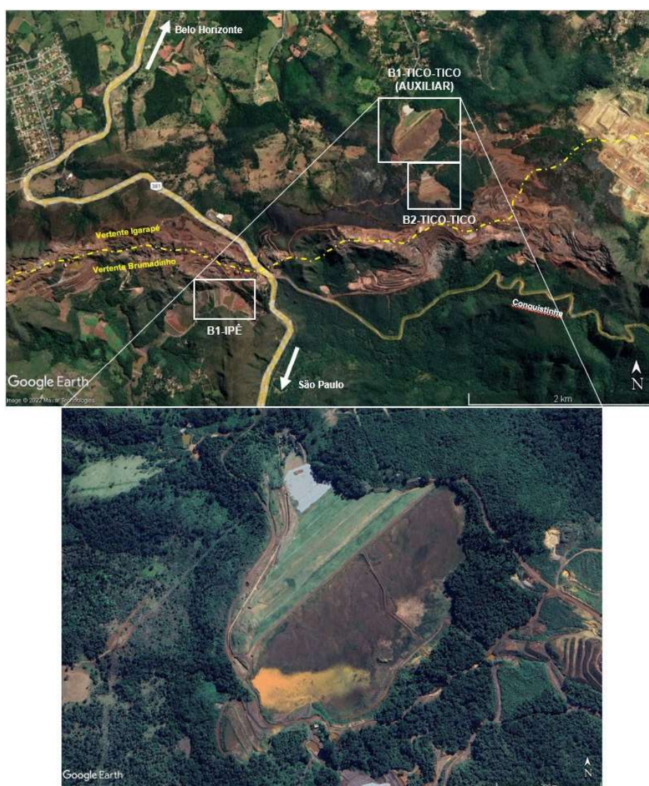
Figura 1. Localização das barragens i) B1 Ipê, na vertente Brumadinho; ii) B2 Tico-Tico, e iii) B1 Auxiliar, ambas na vertente Igarapé. Destaque na barragem B1 Auxiliar, na vertente Igarapé, à leste da BR-381. Coordenadas: E 574450m, N 7776862m. Datum Sirgas 2000.
