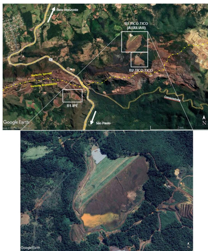
Figura 1. Localização das barragens i) B1 Ipê, na vertente Brumadinho; ii) B2 Tico-Tico, e iii) B1 Auxiliar, ambas na vertente Igarapé. Destaque na barragem B1 Auxiliar, na vertente Igarapé, à leste da BR-381. Coordenadas: 574.430m E / 7.776.830m N. Datum Sirgas 2000.
