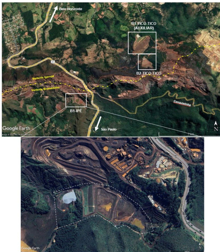
Figura 1. Localização das barragens i) B1 - Mina Ipê, na vertente Brumadinho; ii) B2 Tico-Tico, e iii) B1 Auxiliar, ambas na vertente Igarapé. Destaque na barragem B1 - Mina Ipê, na vertente Brumadinho, à oeste da BR-381 (canto direito da imagem inferior). Coordenadas: 572.390m E / 7.775.120m N. Datum Sirgas 2000.
