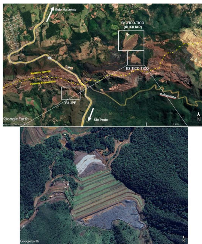
Figura 1. Localização das barragens i) B1 Ipê, na vertente Brumadinho; ii) B2 Tico-Tico, e iii) B1 Auxiliar, ambas na vertente Igarapé. Destaque na barragem B2 Tico-Tico, na vertente Igarapé, à leste da BR-381. Coordenadas: 574.570m E / 7.776.150m N. Datum Sirgas 2000.
